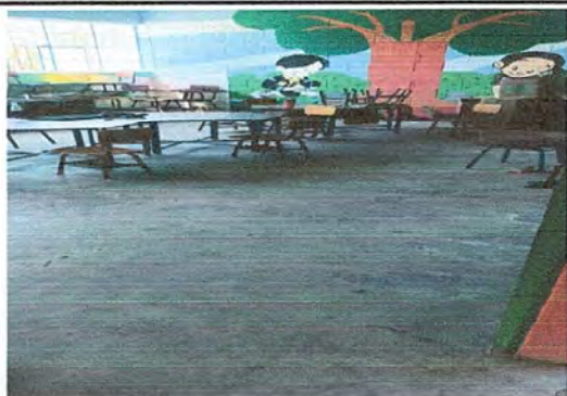
Foto7: Modulo. 1.Cambio de piso de concreto por piso.
