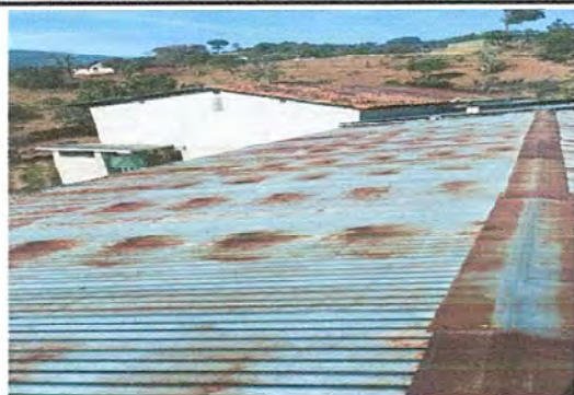
Foto1: Modulo. 1. Cambio laminas por laminas troqueladas de colr cabibre 26.
