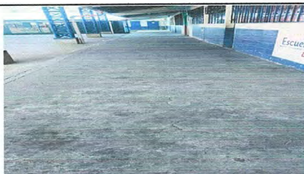
Foto 6: Modulo 1. Cambio de piso de concreto por piso.
