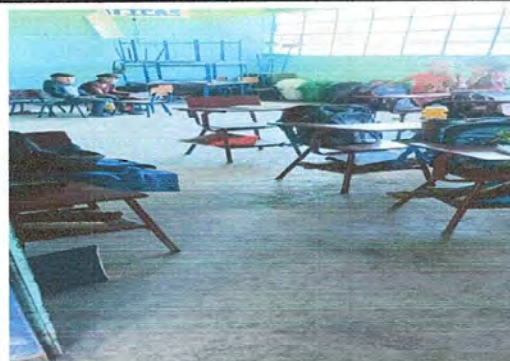
Foto 4: Modulo 1. Cambio de piso de concreto por piso.
