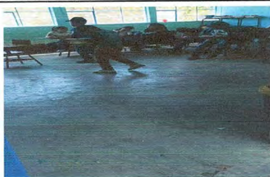
Foto 5: Modulo 1. Cambio de piso de concreto por piso.
