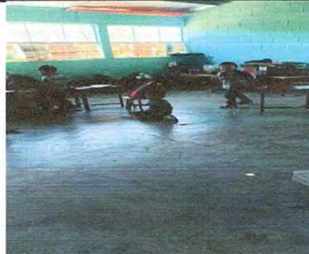
Foto 8: Modulo 1. Cambio de piso de concreto por piso.
