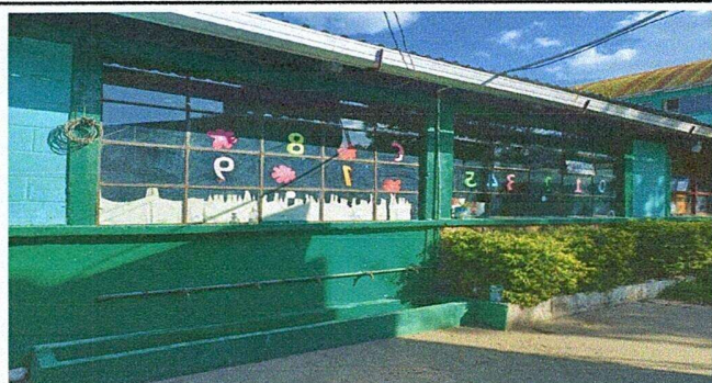
Foto 3: Módulo 1: Sustitución de Ventanas
