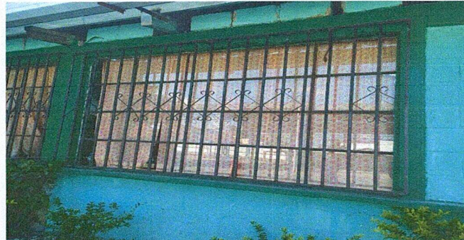
Foto 2: Módulo 1. Sustitución de Balcones
