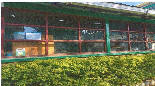
Foto 1: Módulo 1: Sustitución de Ventanas
