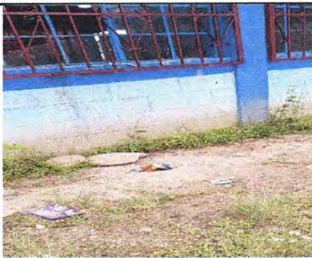
Foto 4: Módulo 1. Pintura en muros exteriores e interiores
