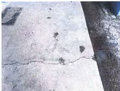
Foto1: Módulo 1. Sustitución de piso de torta de concreto por piso cerámico antideslizante
