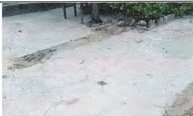
Foto 9: Patio. Sustitución de torta de concreto
