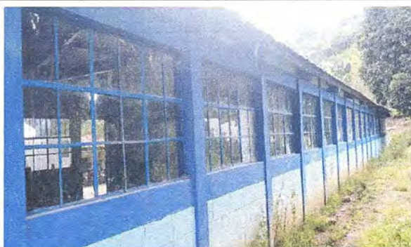
Foto 5: Módulo 1. Suministro e instalación de balcón de hierro en ventana
