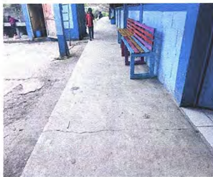
Foto 2: Módulo 1. Sustitución de piso de torta de concreto por piso cerámico antideslizante
