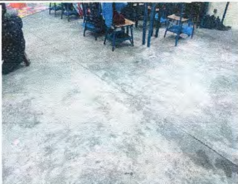
Foto 7: Módulo 2. Sustitución de piso de torta de concreto por piso cerámico
