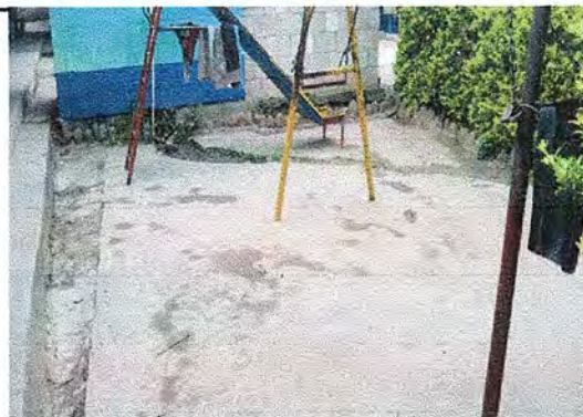
Foto 10: Patio. Sustitución de torta de concreto
