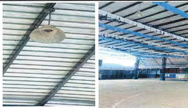
Foto 7: CANCHA POLIDEPORTIVA. Sustitucion de focos ahorradores
