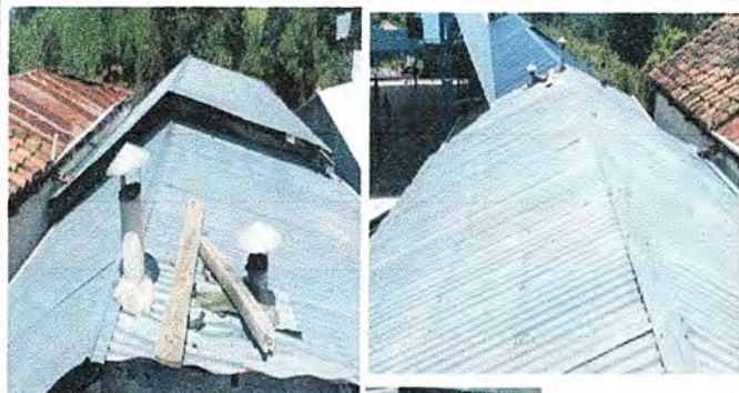
Foto1: Modulo 1. Sustitucion de lamina, por lamina troquelada alucinic calibre 26.
