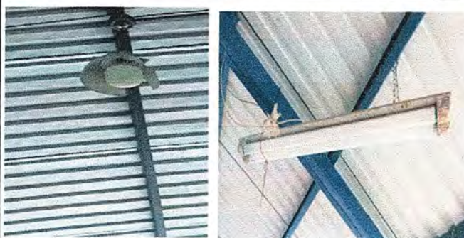
Foto 4: MODULO 1. Sustitucion de focos ahorradores
