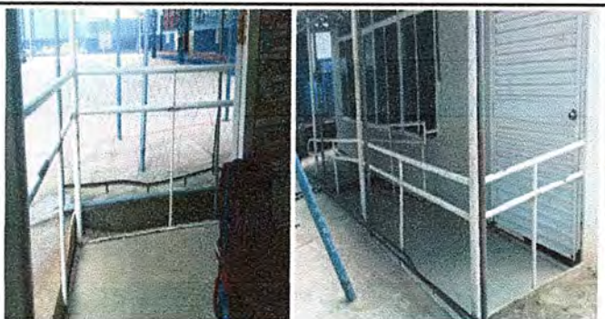
Foto 5: MODULO 2. Sustitucion de barandas de metal.
