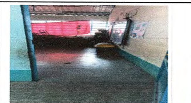
Foto 6: MODULO 3. Sustitucion de torta de cemento por piso ceramico.
