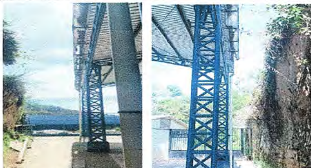
Foto 7: CANCHA POLIDEPORTIVA. Sustitucion de canal de metal por canal de metal.
