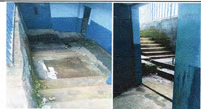
Foto 3: MODULO 1. Reparacion de muro perimetral de block.
