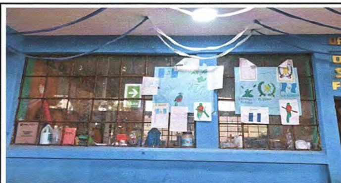
Foto 3: MODULO 1 SUSTITUCIÓN DE VENTANAS DE METAL POR PVC.
