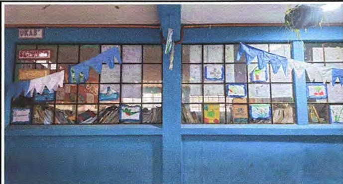
Foto1: MODULO 2 SUSTITUCIÓN DE VENTANAS DE METAL POR PVC.
