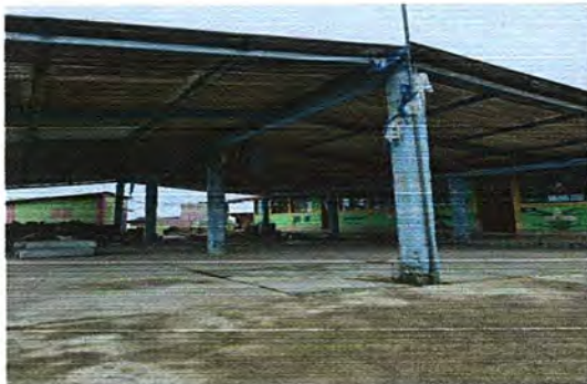
Foto 1: Sustitución de lámina, por troquelada aluzinc calibre 26 y Sustitución de capote
