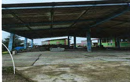
Foto 2: Sustitución de lámina por troquelada, aluzinc calibre 26 y sustitución de capote
