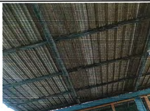
Foto 6: Sustitución de estructura de soporte de madera, por metal
