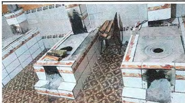
Foto1: Sustrución de planchas de la cocina. Modulo 1
