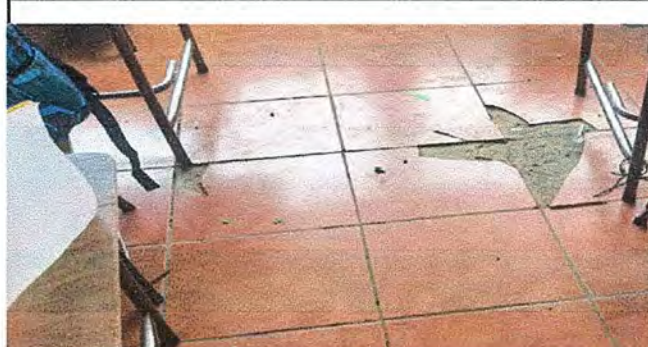
Foto 6: Sustrucion de piso ceramico por piso ceramico.
