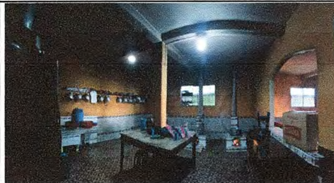
Foto 2: Sustrucion de pintura y piso en el area de la cocina. Modulo 1
