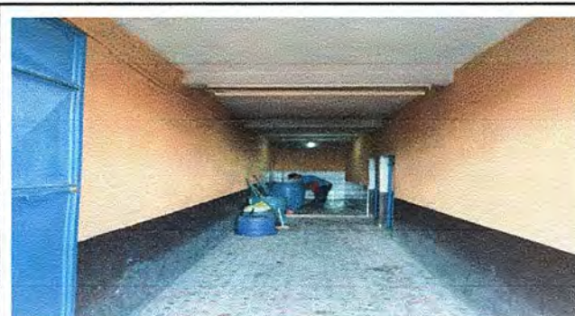
Foto 4: Sustrución de pintura en el pasillo hacia la cocina. Modulo 1.
