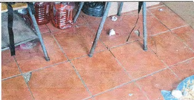
Foto7: Sustrución de piso ceramico por piso ceramico. Aula 2
