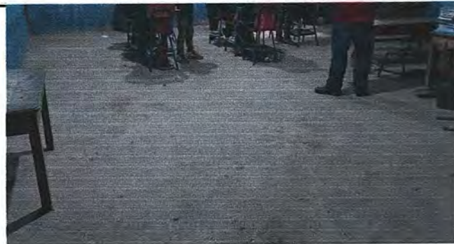
Foto 4: MÓDULO 2. Sustitución de torta de concreto por pisos cerámico.
