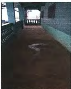
Foto 5: MÓDULO 2. Sustitución de torta de concreto por, piso cerámico.
