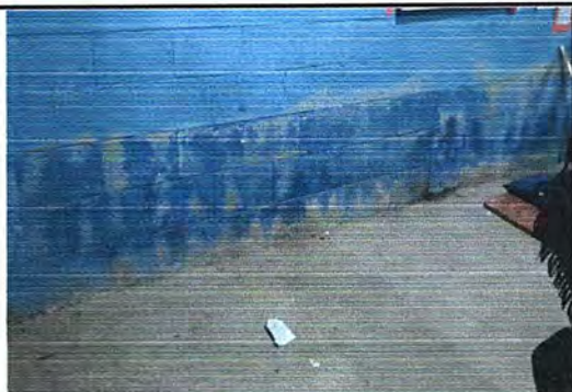
Foto 9: PINTURA GENERAL. Pintura en muros interiores
