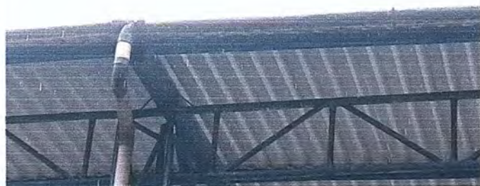
Foto 3: CANCHA TECHADO. Sustitución de PVC, por canal de metal.
