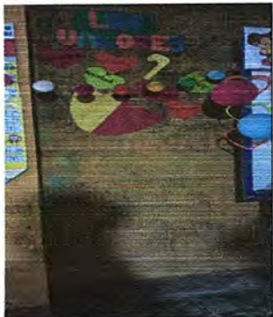
Foto7: PINTURA GENERAL. Pintura en muros interiores.
