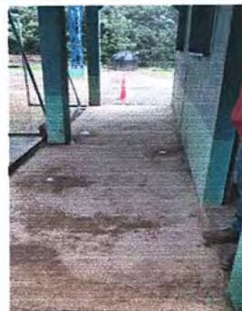
Foto 2: MÓDULO 1. Sustitución de torta de concreto, por piso cerámico.
