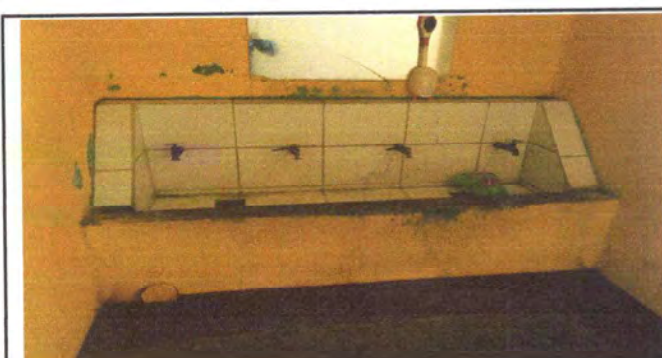
MODULO 6. SUSTITUCIÓN DE AZULEJO
