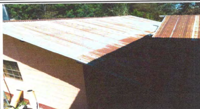
MODULO 2. SUSTITUCIÓN DE LÁMINA, POR LÁMINA TROQUELADA ALUZINC CALIBRE 26
