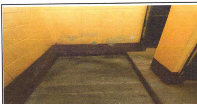
MODULO 6. SUSTITUCIÓN DE PISO CONCRETO, POR PISO ANTIDESLIZANTE
