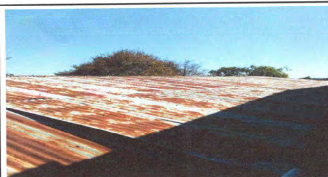
MODULO 3. SUSTITUCIÓN DE LÁMINA, POR LÁMINA TROQUELADA ALUZINC CALIBRE 26.
