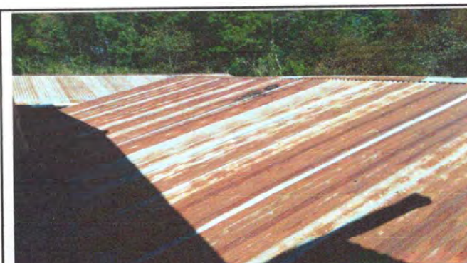
MODULO 5. SUSTITUCIÓN DE LÁMINA, POR LÁMINA TROQUELADA ALUZINC CALIBRE 26.INS
