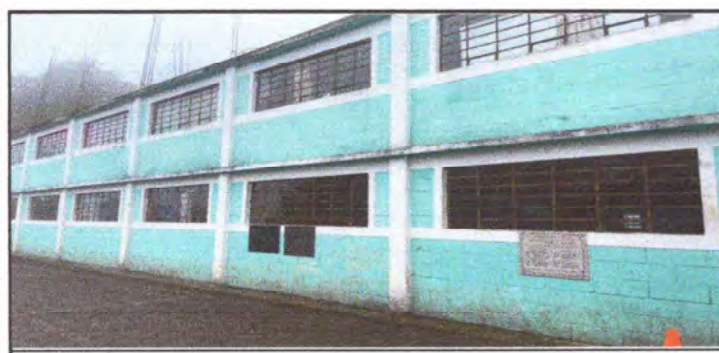
Foto 5: Actualmente la pintura exterior del establecimiento esta deteriorado, se necesita pintar.
