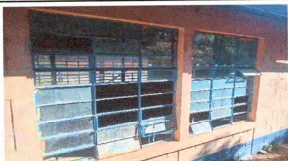
Foto 5: MODULO 2 SUSTITUCIÓN DE VIDRIOS
