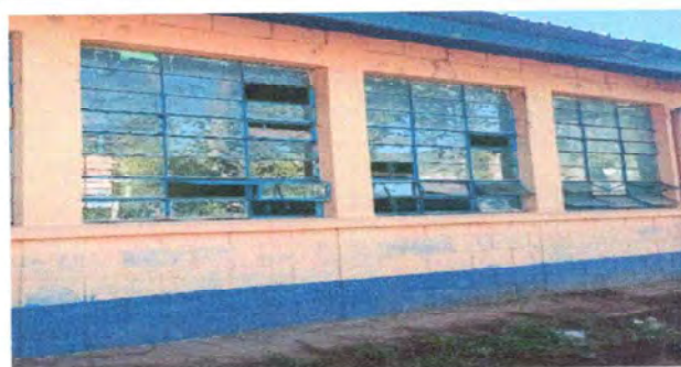
Foto 4: MODULO 2 SUSTITUCIÓN DE VIDRIOS.
