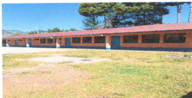
Foto 1: Modulo 2 SUMINISTRO E INSTALACION BALCONES DE HIERRO EN VENTANAS
