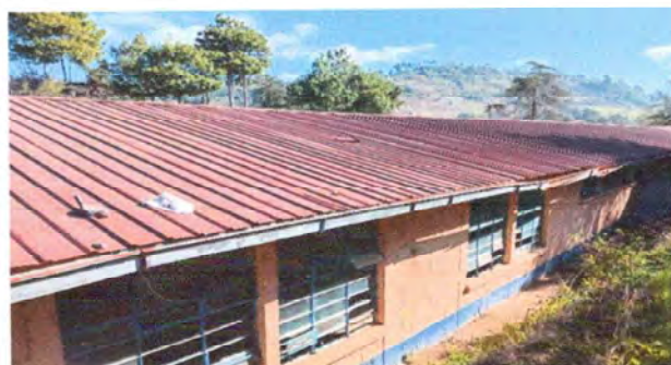
ATRÁS Foto 2: MODULO 2 SUSITUCION DE VIDRIOS.
