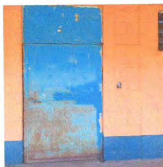
Foto 3: Modulo 2 FABRICACION E INSTALACION DE PUERTA DE METAL EN MODULOS.
