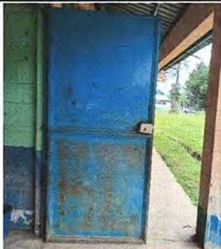
Foto 1: Modulo 3 Sustitución puerta de metal.
