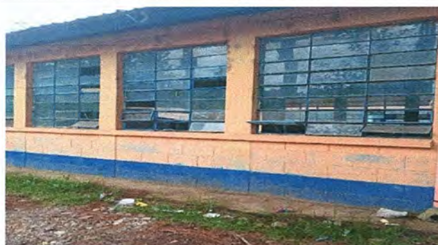
Atrás Foto 4: MODULO 3 Sustitución de vidrios.
