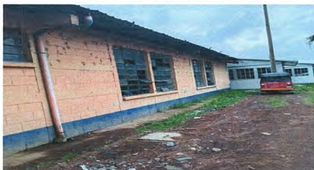
Atrás Foto 5: MODULO 3 Sustitución de vidrios
