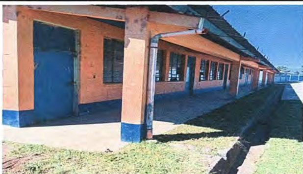
Frente Foto 3: Modulo 3 Sumistro e instalación balcones de hierro en ventanas
