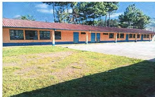
Frente Foto 2: Modulo 3 Suministro e instalación balcones de hierro en ventanas
