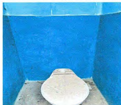
Foto 6: MODULO 2. SUSTITUCIÓN DE INODORO
