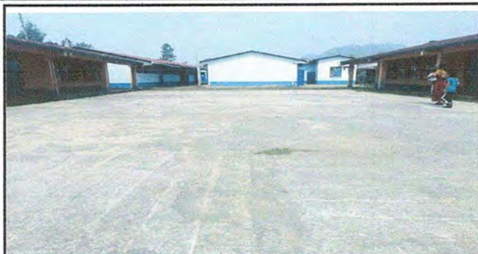
Foto 1: PINTURA GENERAL: PINTURA EN MUROS INTERIOR Y EXTERIOR
