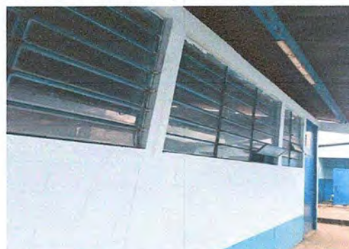
Foto 4: MODULO 1. SUSTITUCIÓN DE LAMPARA E INSTALACIÓN DE UNIDADES DE LUZ.
