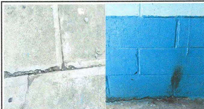
Foto 3: MODULO 3. SUSTITUCIÓN DE PISO DE TORTA DE CONCRETO POR PISO CERAMICA.
