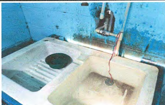
Foto 1: MODULO 2. SUSTITUCIÓN ANTIDESLIZANTE
