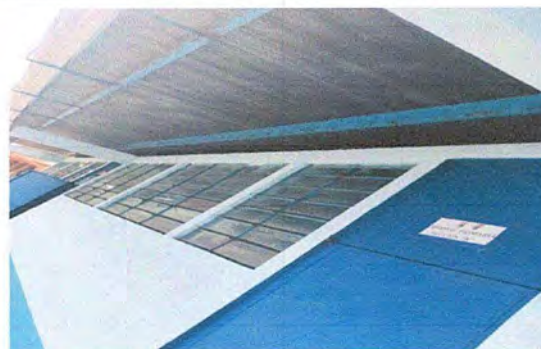
Foto 2: MODULO 1, SUMINISTRO E INSTALACION DE BALCONES
