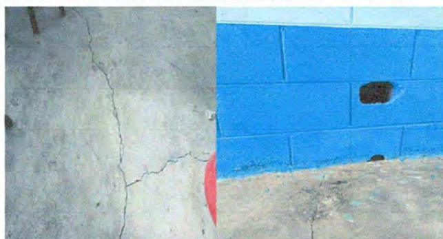
Foto 5: MODULO 1. SUSTITUCIÓN DE PISO DE TORTA DE CONCRETO POR PISO CERAMICA.
