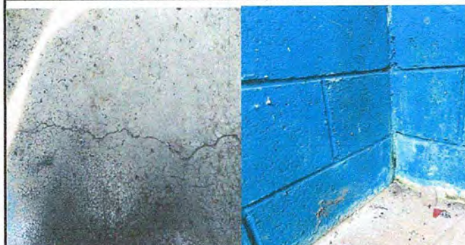
Foto 2: MODULO 2. SUSTITUCIÓN DE PISO DE TORTA DE CONCRETO POR PISO ANTIDESLIZANTE.
