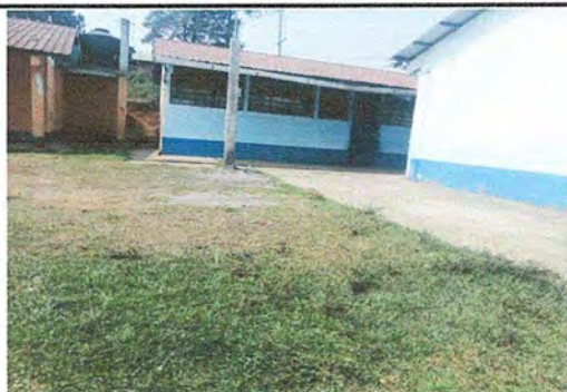
Foto 3: MODULO 1. REPARACION DE CABLEADO ELECTRICO
