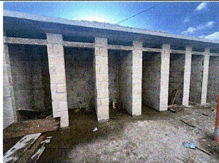
Foto 2: MODULO 3 SUSTITUCIÓN DE INODOROS
