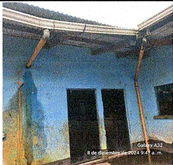
Foto 3: MODULO 2 SUSTITUCIONES DE CANAL POR CANAL NUEVA Y BAJADAS
