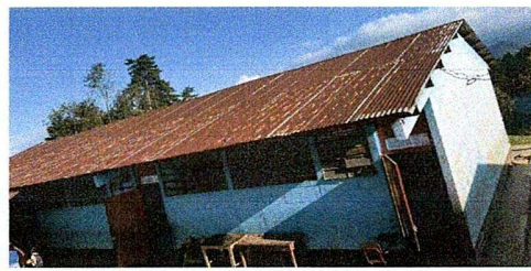
Foto 6: MODULO 1 SUSTITUCIÓN DE LÁMINA DE ZINC POR LÁMINA DE ZINC NUEVA
