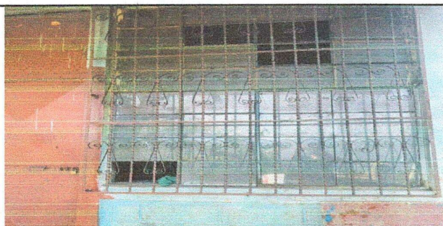
Foto 3: MODULO 1: SUSTITUCION DE BALCÓN DE METAL
