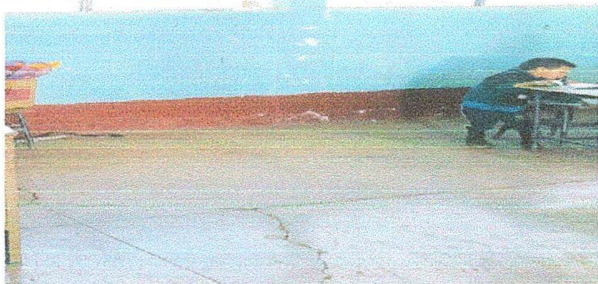
Foto 1: MODULO 1: SUSTITUCION DE PISO DE TORTA DE CONCRETO POR PISO CERAMCA.
