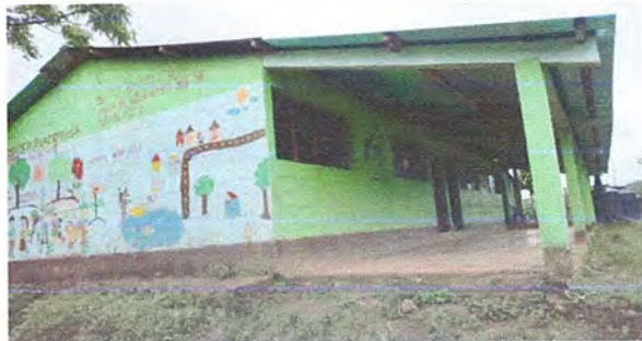
Foto 5: Módulo 1. Pintura en muros exteriores e interiores
