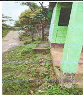
Foto 6: Módulo 1. Reparación de banquetas de concreto
