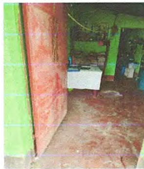
Foto 2: Módulo 1. Sustitución de piso de torta de concreto
