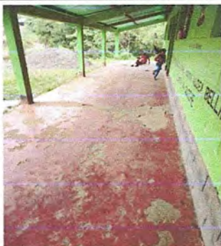
Foto 1: Módulo 1. Sustitución de piso de torta de concreto
