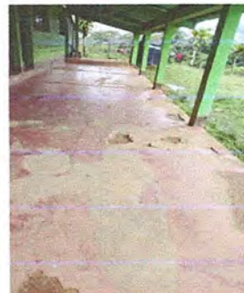
Foto 4: Módulo 1. Sustitución de piso de torta de concreto
