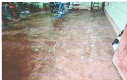
Foto 3: Módulo 1. Sustitución de piso de torta de concreto
