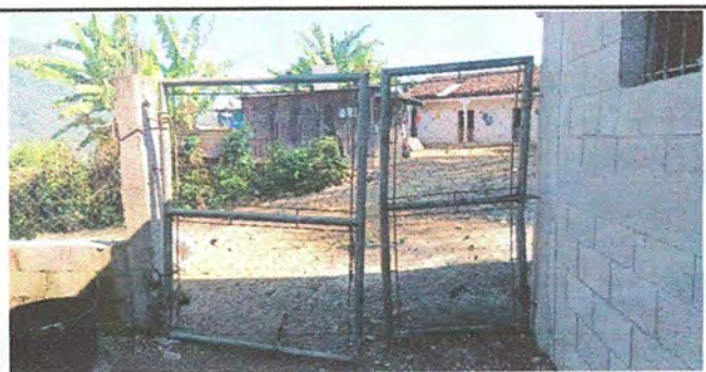
Foto 5: Sustitucion de porton de metal
