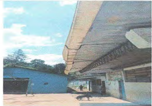
Foto 8: Sustitucion de canal pvc
