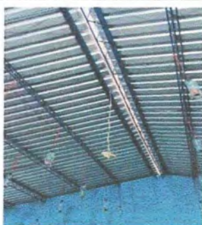
FOTO 5 MODULO 2 REPARACION DE CABLEADO ELECTRICO
