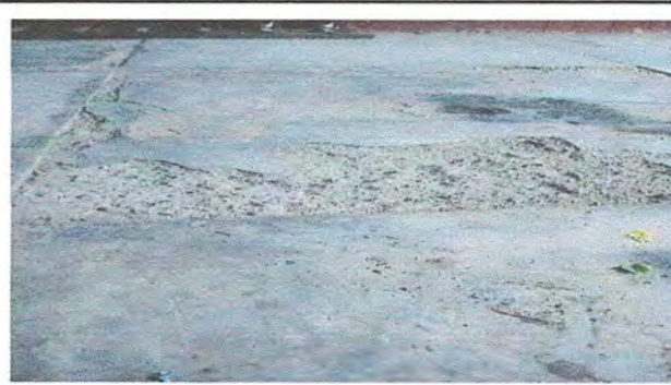
FOTO2 MODULO 2 SUSTITUCION DE PISO DE CONCRETO POR PISO CERAMICO
