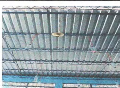
FOTO 4 MODULO 2 SUSTITUCION DE PLAFONERAS
