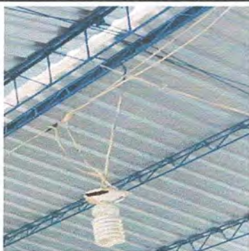
FOTO 3 MODULO 2 SUSTITUCION DE FOCOS AHORRADORES
