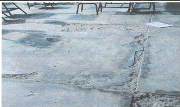
FOTO1 MODULO 1 SUSTITUCION DE PISO CONCRETO POR PISO CERAMICO
