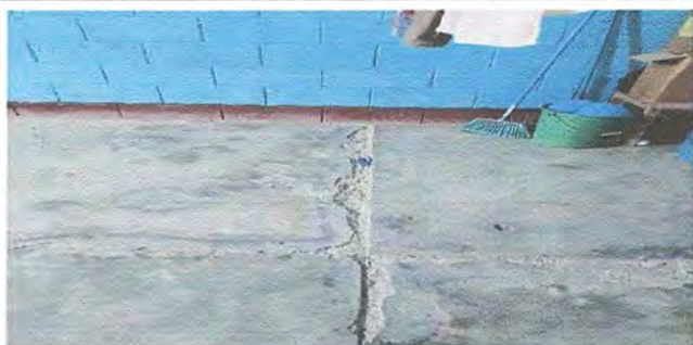
FOTO7 MODULO 3 REPARACIÓN DE PISO DE CONCRETO POR PISO CERÁMICO
