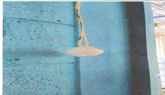
FOTO 6 MODULO 2 SUSTITUCION DE INTERRUPTORES SIMPLE
