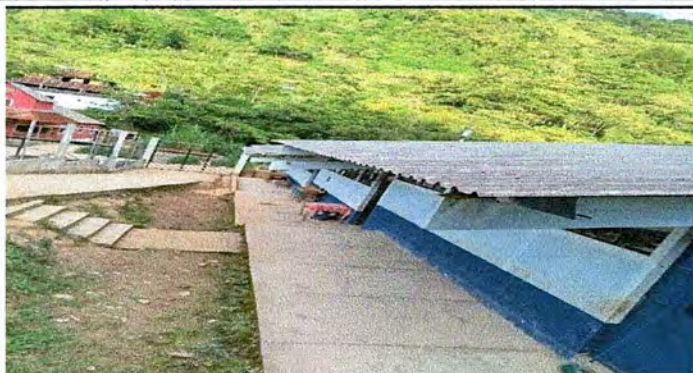
Foto 1: MODULO 1. Suministro e instalacion de canales pvc, instalacion de soportes o pescantes para canal.
