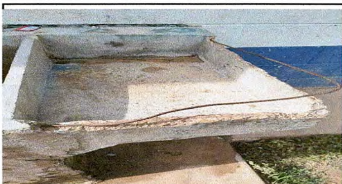
Foto 4: MODULO 2. Sustitucion de pila de cemento de 2 lavaderos
