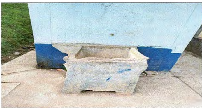
Foto 6: BAÑOS: Sustitucion de pila de concreto de 2 lavaderos.
