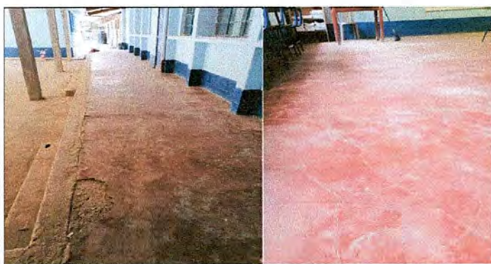
Foto 5: MODULO 3. Sustitucion de piso de torta de concreto por piso cerámico.
