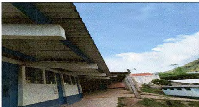
Foto 3: MODULO 2. Suministro e instalacion de canales pvc, instalacion de soporte o pescante pvc para canal.
