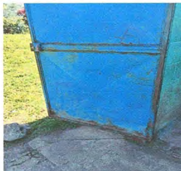
FOTO 8 MODULO 2 SUSTITUCION DE PUERTA
