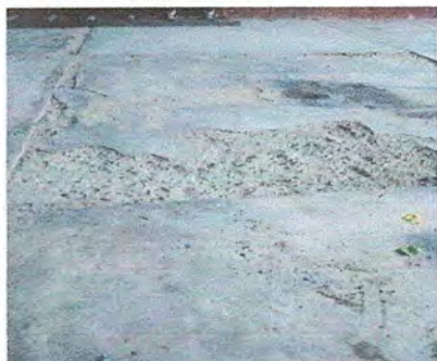
Foto1: MODULO 1 REPARACIÓN DE PISO DE TORTA DE CONCRETO POR PISO CERÁMICO
