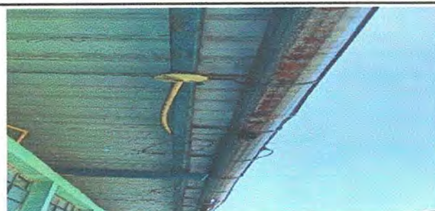
FOTO 6 MODULO 2 SUSTITUCION DE CANAL PVC
