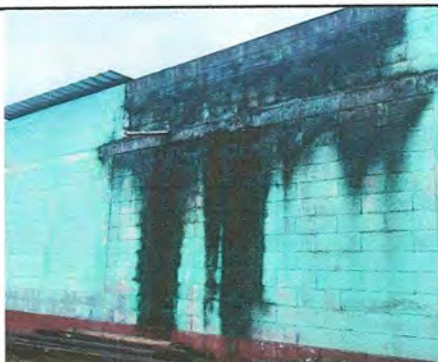
FOTO 9 APLICACIÓN DE PINTURA EN MURO EXTERIOR E INTERIOR
