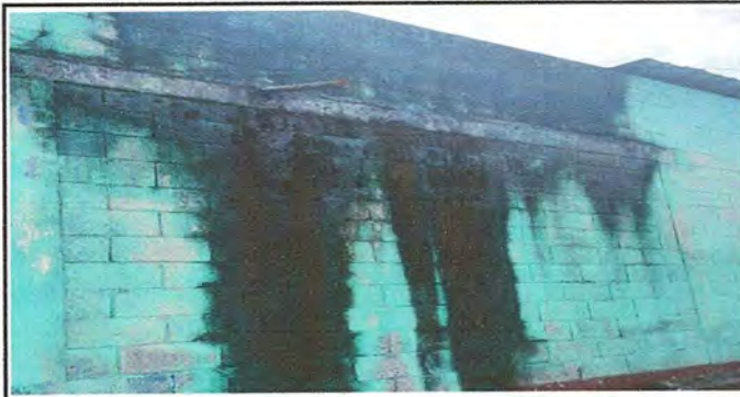
FOTO 10 APLICACIÓN DE PINTURA EN MURO EXTERIOR E INTERIOR
