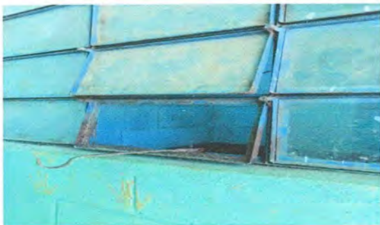
FOTO 7 MODULO 2 SUSTITUCION DE VIDRIOS
