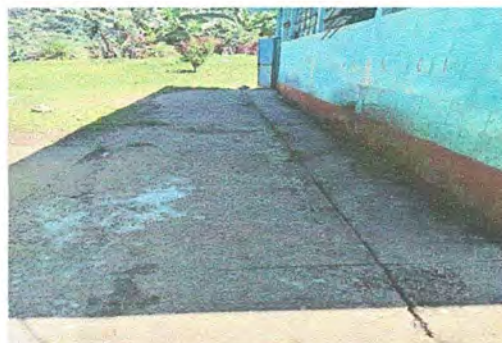
Foto 2 MODULO 1 REPARACIÓN DE PISO DE TORTA DE CONCRETO
