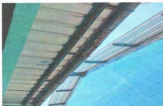
Foto 3 MODULO 1 SUSTITUCION DE CANAL PVC
