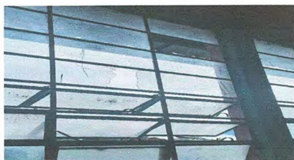
FOTO 4 MODULO 1 SUSTITUCION DE VIDRIOS
