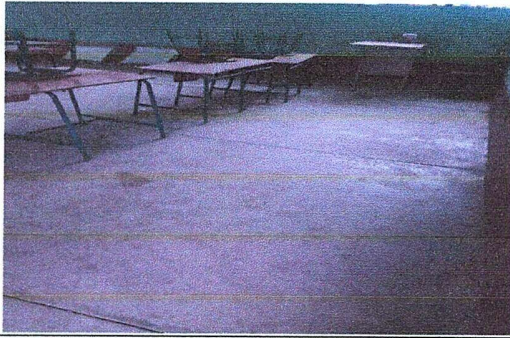
FOTO 1 MODULO 1 SUSTITUCION DE PISO DE TORTA DE CONCRETO POR CERAMICO
