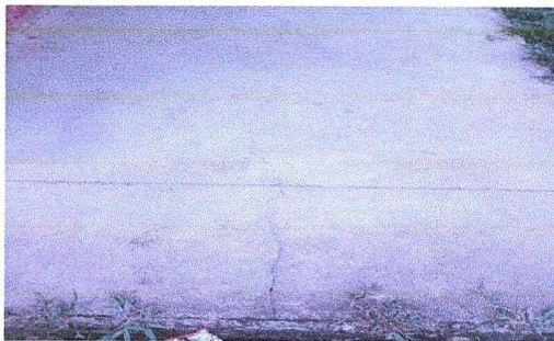
FOTO 5 MODULO 3 SUSTITUCION DE PISO ANTIDEZLIZANTE
