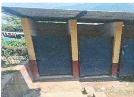
Foto 9: BAÑOS "A". Mantenimiento a estructura de puerta (lijado, cambio de tubo, cepillado, sujeciones, aplicación de pintura).
