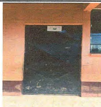
Foto 10: MODULOS 2. Mantenimiento a estructura de puerta (lijado, cambio de tubo, cepillado, sujeciones, aplicación de pintura).
