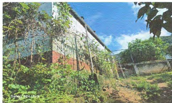
Foto 2: MURO PERIMETRAL. Reparación de muro perimetral de block con tubo hg y malla galvanizada, soleras intermedias y columnas.
