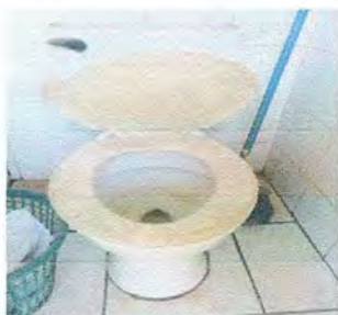
Foto 5: BAÑOS "A". SUSTITUCIÓN DE INODOROS
