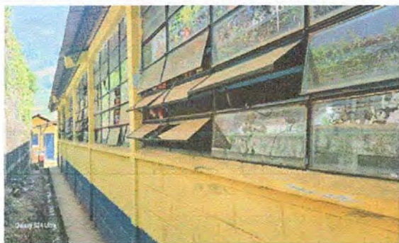
Foto 3: PINTURA GENERAL. Pintura en muros exteriores
