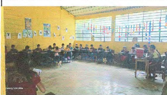
Foto 4: PINTURA GENERAL. Pintura en muros interiores
