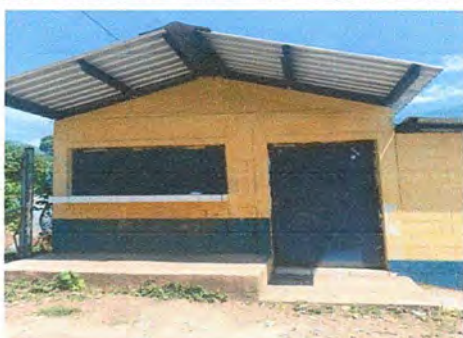
Foto 11: COCINA. Mantenimiento a estructura de puerta (lijado, cambio de tubo, cepillado, sujeciones, aplicación de pintura).
