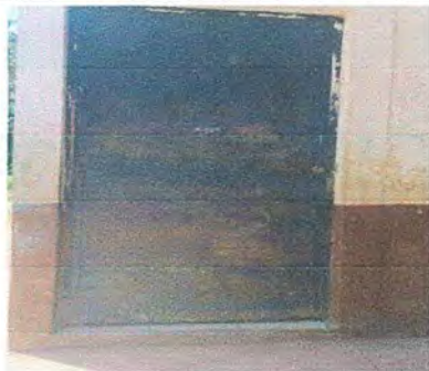
Foto 13: AULA SEXTA "A". Mantenimiento a estructura de puerta (lijado, cambio de tubo, cepillado, sujeciones, aplicación de pintura).
