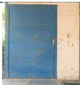
Foto 12: AULA PREFABRICADA. Mantenimiento a estructura de puerta (lijado, cambio de tubo, cepillado, sujeciones, aplicación de pintura).
