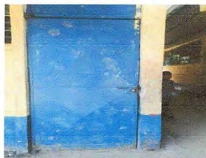
Foto 8: MODULOS 1. Mantenimiento a estructura de puerta (lijado, cambio de tubo, cepillado, sujeciones, aplicación de pintura).
