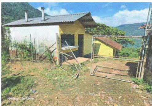
Foto 1: MURO PERIMETRAL. SUSTITUCIÓN DE PORTÓN DE METAL
