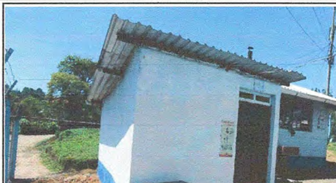
FOTO 20: BODEGA: SUSTITUCIÓN DE LAMINA POR LAMINA TROQUELADA ALUZINC.
