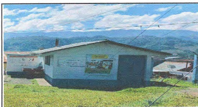
FOTO 17: COCINA: MANTENIMIENTO A ESTRUCTURA DE PUERTA (LIJADO, CAMBIO DE TUBO, CEPILLADO,SUJECCIONES, APLICACIÓN E PINTURA.
