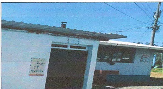
FOTO 21: BODEGA: MANTENIMIENTO A ESTRUCTURA DE PUERTA ( lijado, cambio de tubo, cepillado, sujecciones, aplicación de pintura)
