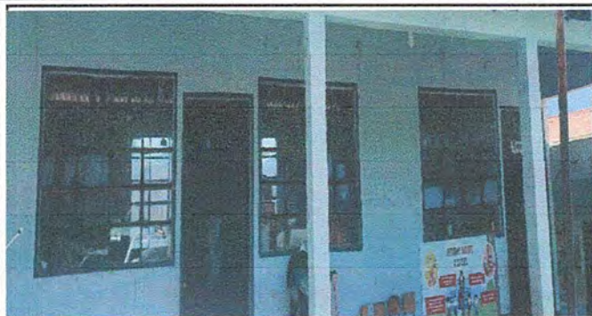
FOTO 1 MODULO 1: MATENIMIENTO A ESTRUCTURA DE PUERTA, LIJADO, CAMBIO DE TUBO, CEPILLADO, SUJECCIONES Y APLICACIÓN DE PINTURA.
