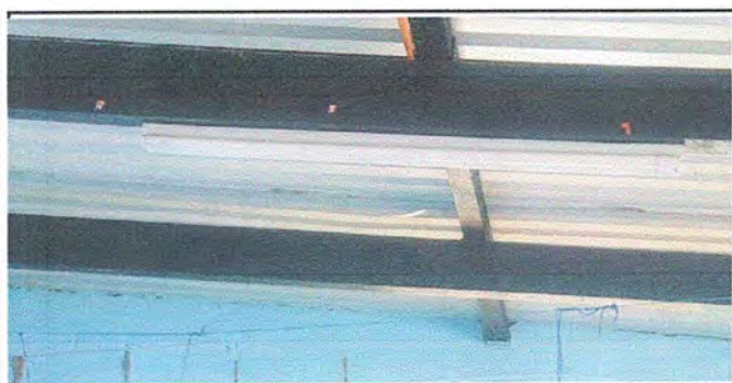
FOTO 5 MODULO 1 SUSTITUCION DE LAMPARAS TIPO LED
