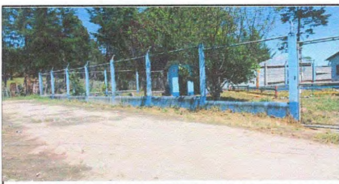
FOTO 23: PINTURA EN GENERAL: PINTURA EN MUROS INTERIORES Y EXTERIORES.
