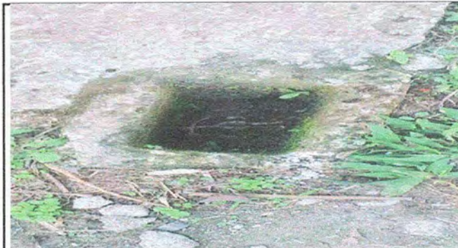
BAÑO A: FOTO 12 SUSTITUCION DE LLAVE DE PASO
