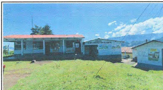
FOTO 22: PINTURA GENERAL: PINTURA EN MUROS INTERIORES Y EXTERIORES
