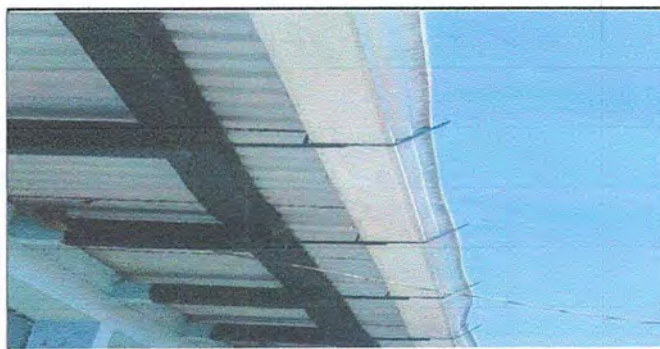
FOTO 6 MODULO 1 SUSITUCION DE CANAL PVC
