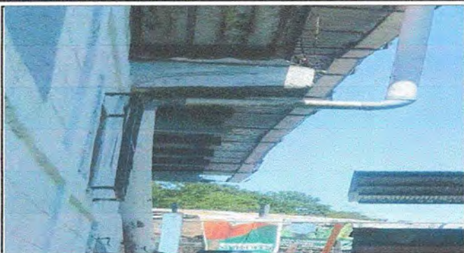
FOTO 7 MODULO 1 SUSTITUCION DE BAJADA DE AGUA PLUVIAL TUBO DE PVC 3"
