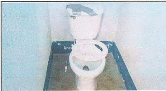
FOTO 10: BAÑO A INSTALACION DE TAPADERA DE SANITARIOS
