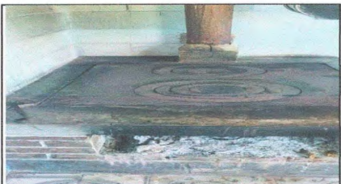
FOTO 16: COCINA: INSTALACION DE AZULEJO
