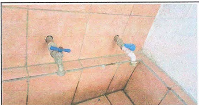
FOTO 11: BAÑO A SUSTITUCION DE GRIFOS
