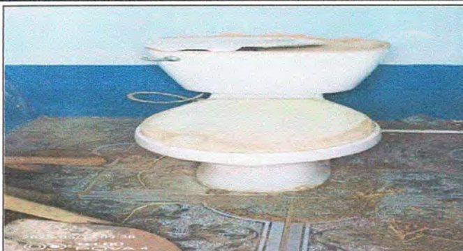
FOTO 13: BAÑO B: SUSTITUCIÓN DE INODORO
