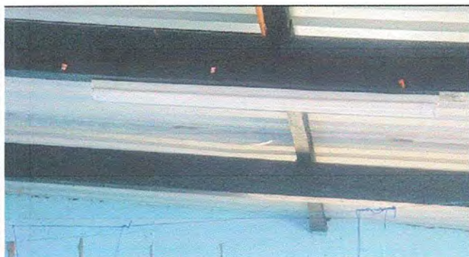
FOTO 3: MODULO 1 SUSTITUCION DE ESTRUCTURA DE SOPORTE DE MADERA POR METAL
