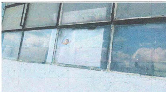
FOTO 4 MODULO 1 SUSTITUCION DE VIDRIOS
