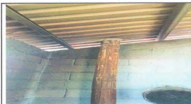
FOTO 15: COCINA: SUSTITUCION DE CHIMENEA DE METAL POR CONCRETO
