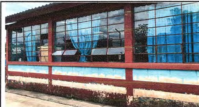
Foto7: MODULO 1: pintura en muro exterior.
