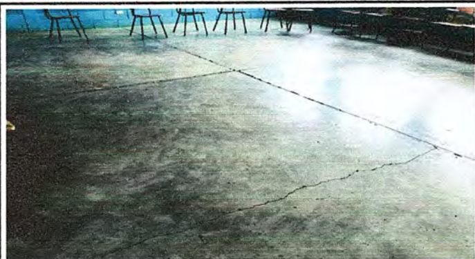
Foto1: MODULO 1: Sustrucción de torta de cemento por piso ceramico (en aulas)
