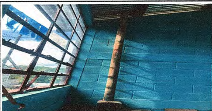
Foto 5: MODULO 2: sustitución de chimenea de metal.
