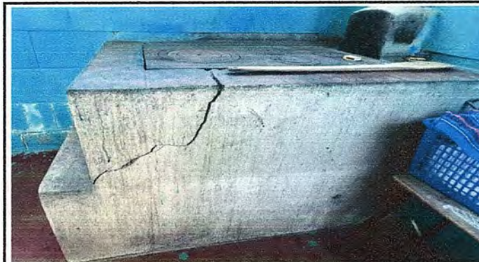
Foto 4: MODULO 2 Instalación de azulejo en estufa rural
