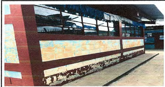
Foto 6: MODULO 3: pintura en muro exterior.
