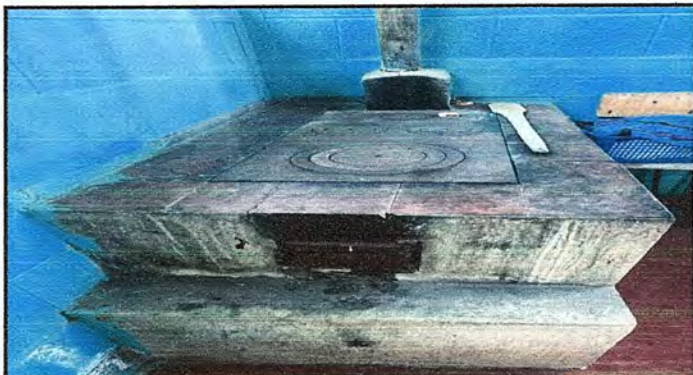
Foto 3: MODULO 2: Sustrucción de plancha de metal de 3 hornillas
