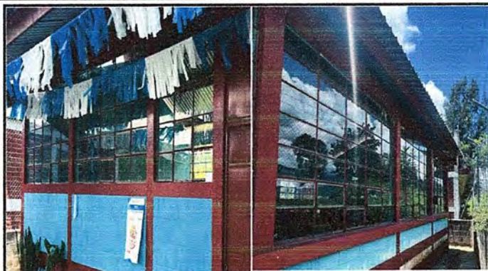
Foto 2: MODULO 1: Sustrucción de balcones de metal
