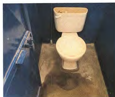
Foto 6: MÓDULO 4 : Sustitución de inodoro
