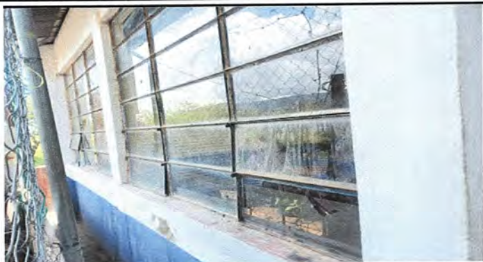
Foto 1: MÓDULO 1: Suministro e instalación de balcón de hierro en ventana.
