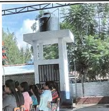
Foto 3: MÓDULO 3: Sustitución depósito de agua 1700ml
