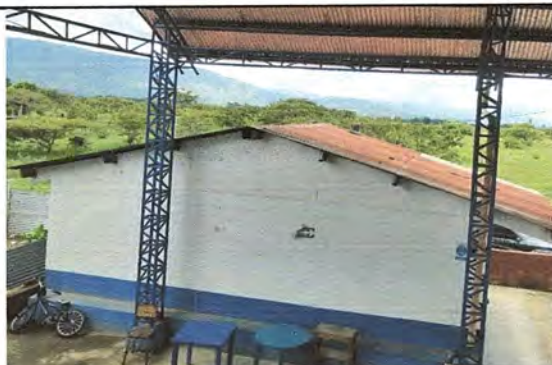
Foto 10: TECHADO DE PATIO. Mantenimiento a estructura de soporte de metal.
