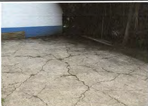
Foto 11. Reparación de planchas de concreto de patio
