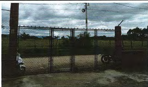
Foto 15. MURO. Mantenimiento a portón de metal
