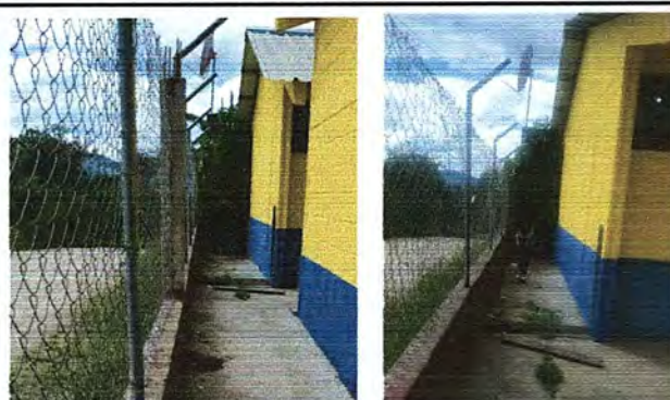
Foto 14 MURO. Fabricación e instalación de puerta con rejas .
