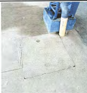
Foto 9: TECHADO DE PATIO. Mantenimiento a caja de registro.
