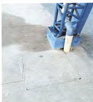
Foto 5: MÓDULO 3: sustitución de tubería principal.
