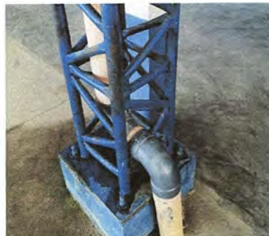
Foto 8: TECHADO DE PATIO. Reparación de bajada de agua pluvial, tubo PVC 3"
