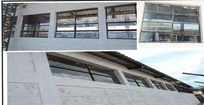
Foto 2: MÓDULO 2: Suministro e instalación de balcón de hierro en ventana.
