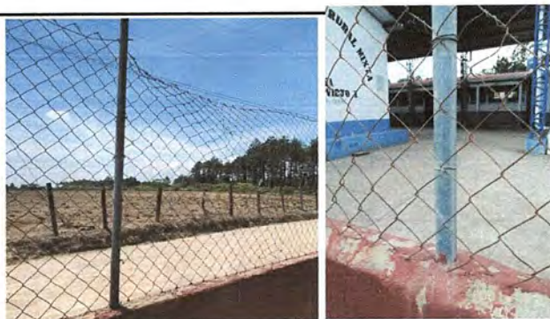
Foto 12 MURO PERIMETRAL. Reparación de tubo hg y malla galvanizada
