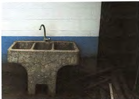
Foto 7: Módulo 4: Sustitución de pila de cemento de dos lavadero
