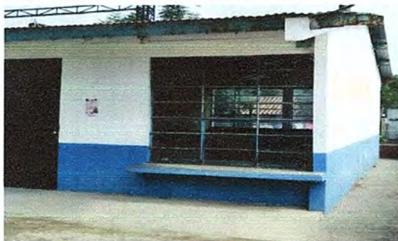
Foto 5: MÓDULO 3: Suministro e instalación de balcón de hierro en ventana.
