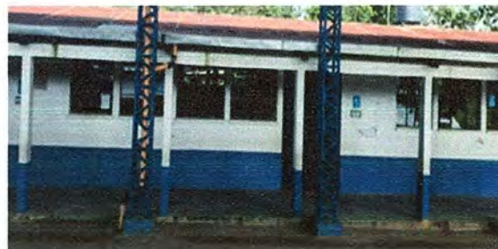
Foto 2: MÓDULO 2: Suministro e instalación de balcón de hierro en ventana.
