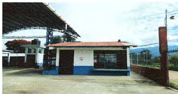
Foto 6: MÓDULO 3: Sustitución de lámina, por lámina troquelada aluzinc calibre 26
