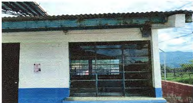
Foto 7: MÓDULO 3: Mantenimiento a estructura de metal.
