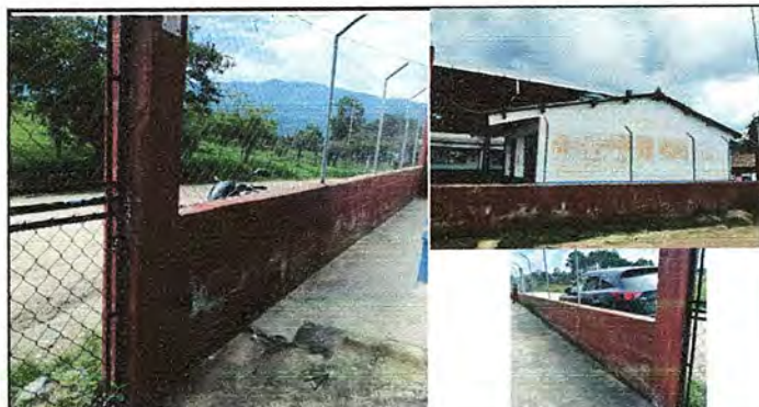
Foto 8: MÓDULO 4: Pintura de muros exteriores e interiores
