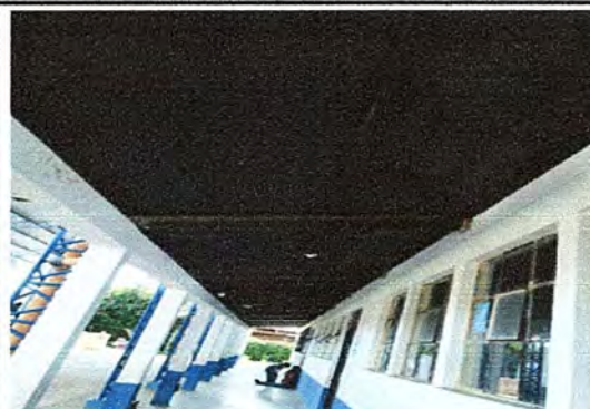
Foto 4: MÓDULO 2: Mantenimiento a estructura de soporte de metal.
