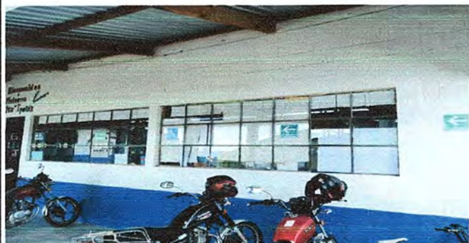
Foto 1: MÓDULO 1: Suministro e instalación de balcón de hierro en ventana.
