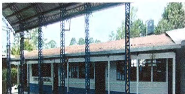
Foto 3: MÓDULO 2: Sustitución de lámina, por lámina troquelada aluzinc calibre 26
