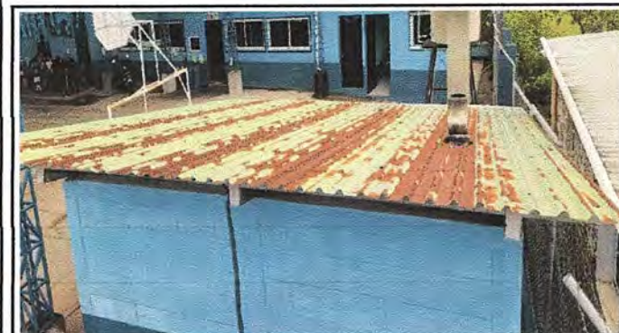
Foto 3, módulo 2 : Sustrucción de lámina, por lámina troquelada aluzinc calibre 26.
