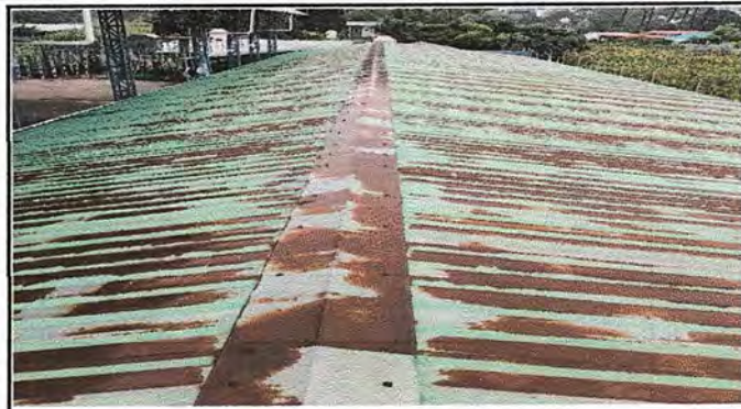
Foto 2, módulo 1: Sustrucción de capote para lámina troquelada.
