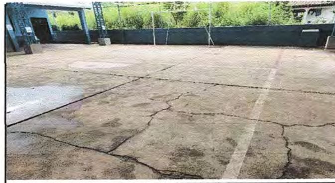
Foto 6 cancha polideportiva: Reparación de planchas de concreto de patio.
