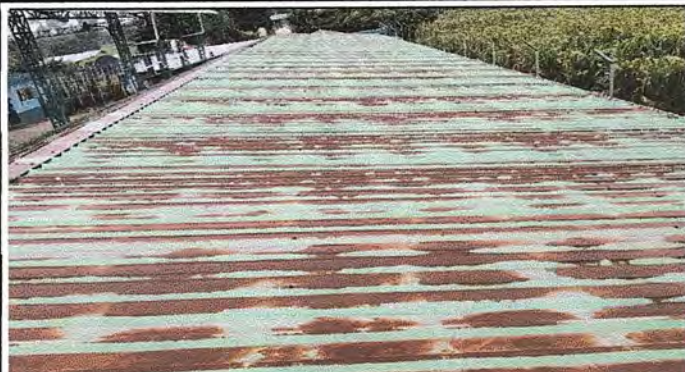
Foto 1, módulo 1: Sustrucción de lámina, por lámina troquelada aluzinc calibre 26.
