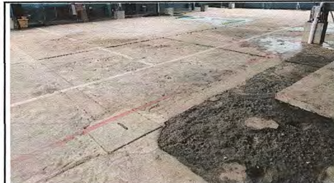
Foto 4, cancha polideportiva: Reparación de planchas de concreto de patio.
