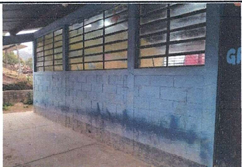
Foto 5: Pintura general. Pintura en muros exteriores e interiores.
