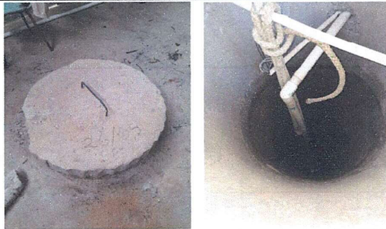
Foto 4: Área de pozo. Sustitución de bomba sumergible más accesorios.
