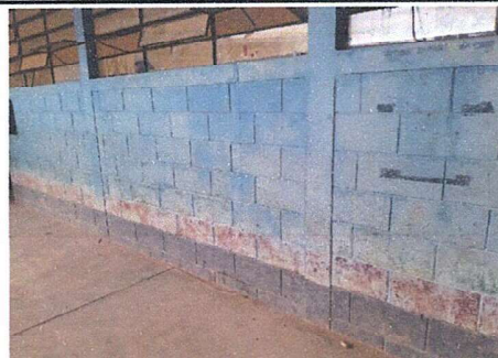
Foto 6: Pintura general. Pintura en muros exteriores e interiores.
