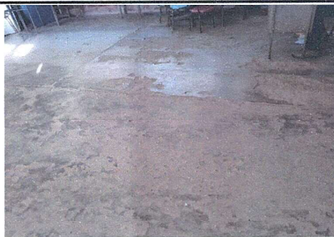
Foto 2: Módulo 1. Sustitución de piso de torta de concreto por piso cerámico.
