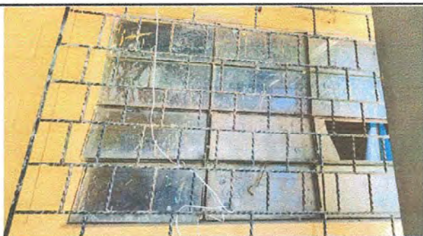
Foto 5: Módulo 2 sustitución de ventanas de metal por PVC blanco más vidrio
