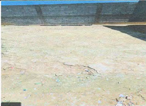
Foto 7: PATIO. Reparación de planchas de concreto de patio
