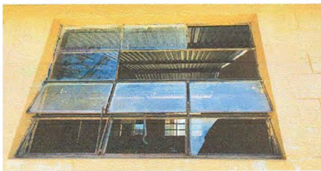
Foto 3 Módulo 1: Fabricación e instalación de balcones de metal
