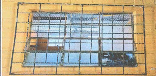
Foto 1 Módulo 1: sustitución de ventanas de metal por PVC blanco más vidrio
