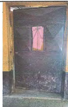
Foto 6: Módulo 2: Sustitución de puerta de metal por metal
