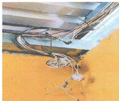
Foto 4 Módulo 1: Reparación de cableado eléctrico
