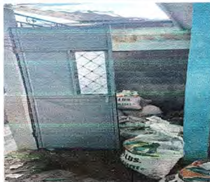
Foto 8: MODULO 2. Sustitución de puerta.
