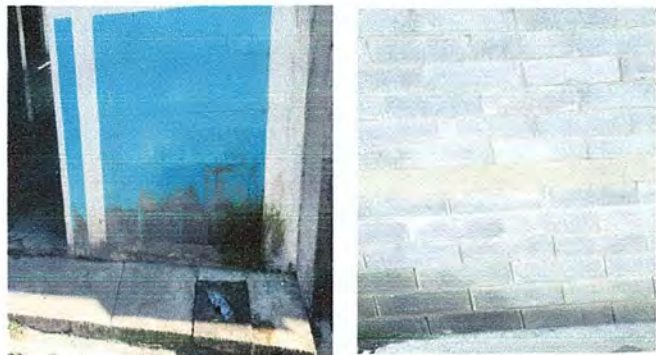
Foto1: MODULO 1. Pintura en muros exteriores e interiores.
