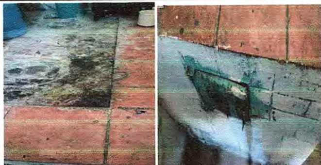
Foto7: MODULO 2. Sustitución de estufa de completa incluida chimenea y plancha de metal.
