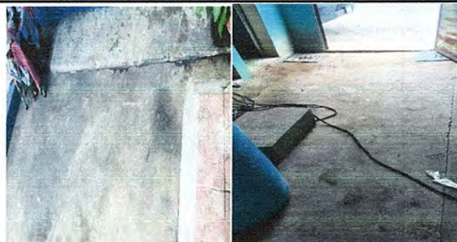
Foto 4: PATIO. Sustitución de torta de concreto por piso baldosa.
