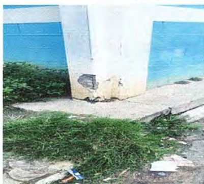
Foto 3: MODULO 1. Sellado de grietas y fisuras en muros.
