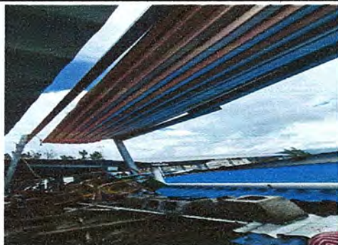
Foto 5: MODULO 2. Sustitución de lámina, por lámina troquelada aluzinc calibre 26.
