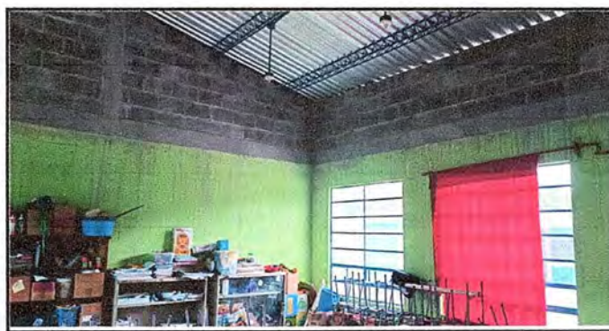
Foto No.12 Módulo 6: Pintura en muros exteriores e interiores
