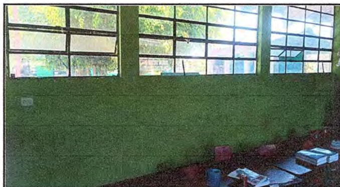
Foto No. 10 Módulo 5: Pintura en muros exteriores e interiores
