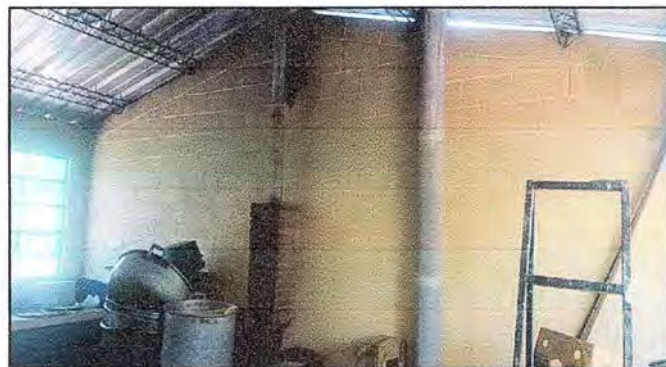
Foto No. 4 Módulo 2: Pintura en muros exteriores e interiores
