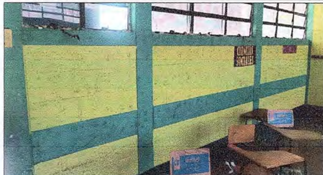
Foto No. 2 Módulo 1: Pintura en muros exteriores e interiores
