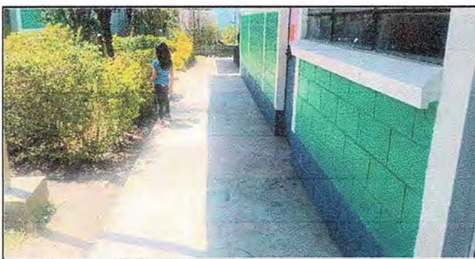
Foto No. 5 Módulo 3: Reparación de piso de torta de concreto por piso cerámico
