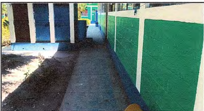
Foto No. 9 Módulo 5: Reparación de piso de torta de concreto por piso cerámico
