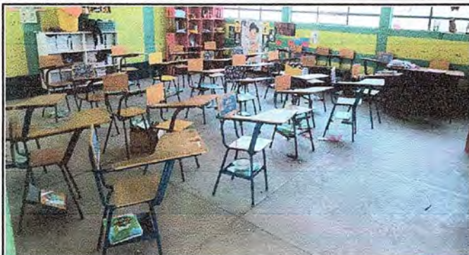
Foto No. 1 Módulo 1: Reparación de piso de torta de concreto por piso cerámico
