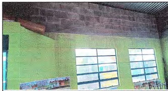
Foto No. 6 Módulo 3: Pintura en muros exteriores e interiores
