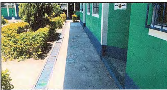
Foto No.11 Módulo 6: Reparación de piso de torta de concreto por piso cerámico
