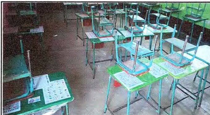
Foto No. 7 Módulo 4: Reparación de piso de torta de concreto por piso cerámico
