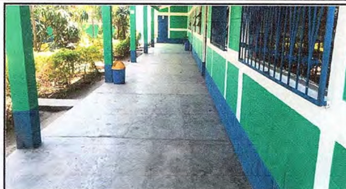
Foto No. 8 Módulo 4: Reparación de piso de torta de concreto por piso cerámico
