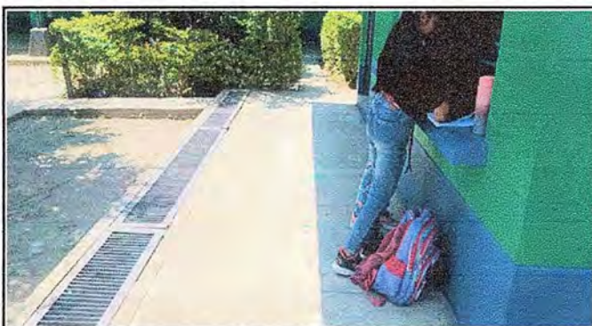
Foto No. 3 Módulo 2: Reparación de piso de torta de concreto por piso cerámico
