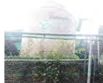
Foto 4: MODULO 2: Sustitución de depósito de agua 1700 LT
