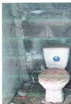
Foto 3: MODULO 2: Sustitucion de inodoros
