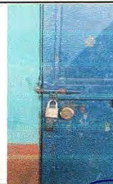
Foto 6: MODULO 3: Sustitución e instalación de lámina de puerta
