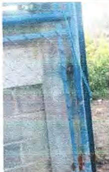
Foto 7: MURO PERIMETRAL: Mantenimiento a porton de metal
