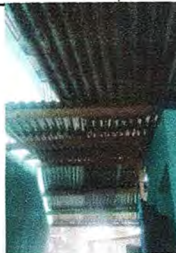
Foto 2: MODULO 2: Sustitución e instalación de lámina por lámina troquelada aluzinc calibre 26, sustitución e instalación portante de madera por metal
