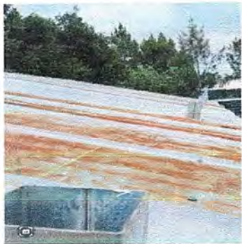
Foto1: MODULO 1: Sustitución e instalacacion de lámina por lámina troquelada aluzinc calibre 26
