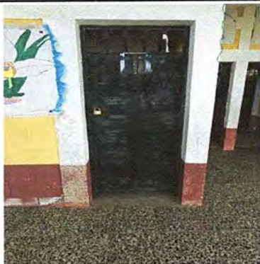
Foto1: Modulo 1. Mantenimiento a estructura de puerta (lijado, cepillado, sujeciones, aplicación de pintura)
