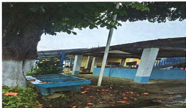
Foto 3: Modulo 1. Sustitución de pila de cemento de dos lavadero
