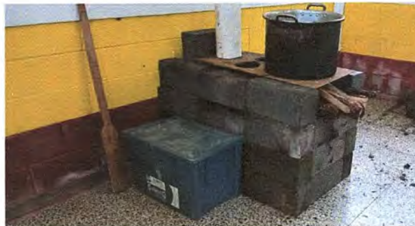
Foto 2: Modulo 1. Sustitución de estufa rural (completa) incluye chimenea y plancha de metal
