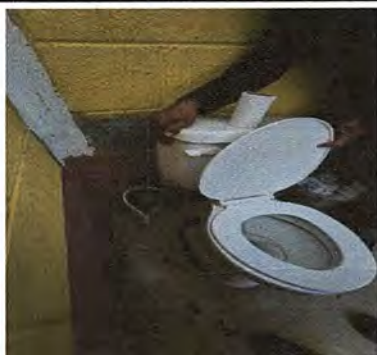
Foto 5: Modulo 1. Sustitución inodoro
