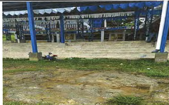
Foto 8: PATIO. Reparación de planchas de concreto de patio
