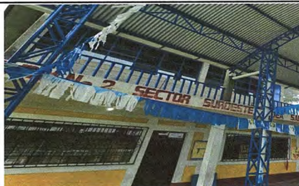
Foto 4: Modulo 1 Sustitución de barandas de metal
