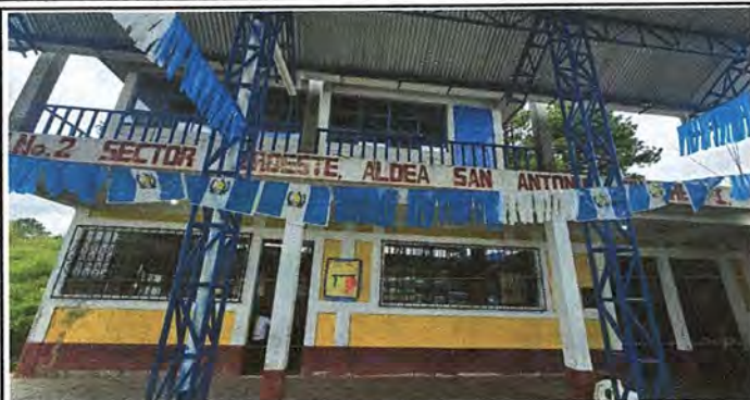
Foto7: Modulo 1. Pintura en muros exteriores e interiores
