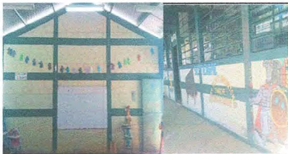
Foto 6: Módulo 2: Pintura en muros exteriores e interiores
