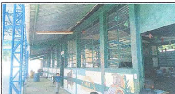
Foto 3: Módulo 2: Suministro e instalación de balcón de hierro de ventanas
