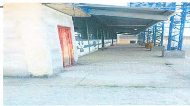
Foto 12: Modulo 2: Sustitución de piso de torta de concreto por piso granito.
