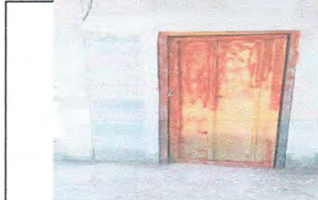
Foto 2: Módulo 2: Sustitución de puerta de madera, por puerta de metal.
