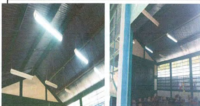
Foto 10: Modulo 2: sustitución de lamparas tipo led
