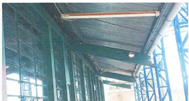
Foto 7: Modulo 2: Sustitución de focos ahorradores
