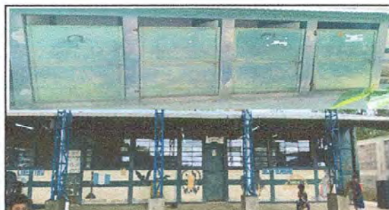
Foto 4: Módulo 2: Mantenimiento a estructura de puertas (lijado, cambio de tubo, cepillado, sujeciones. Aplicación de pintura)
