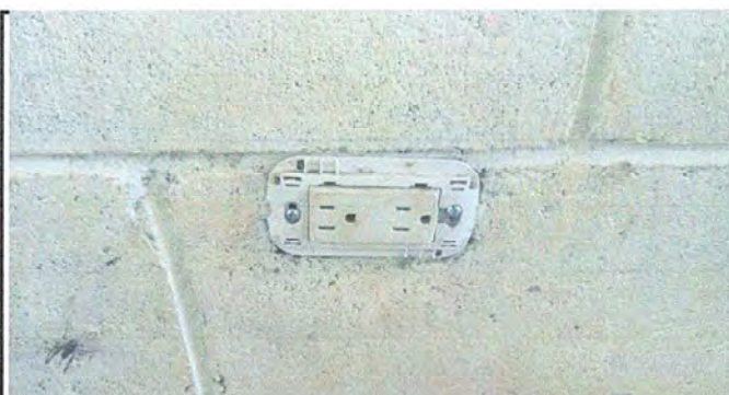
Foto 9: Modulo 2: Sustitución de tomacorrientes dobles
