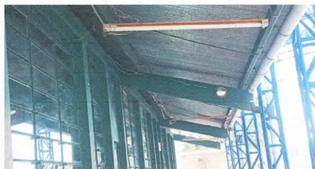
Foto 8: Modulo 2: Sustitución de plafoneras
