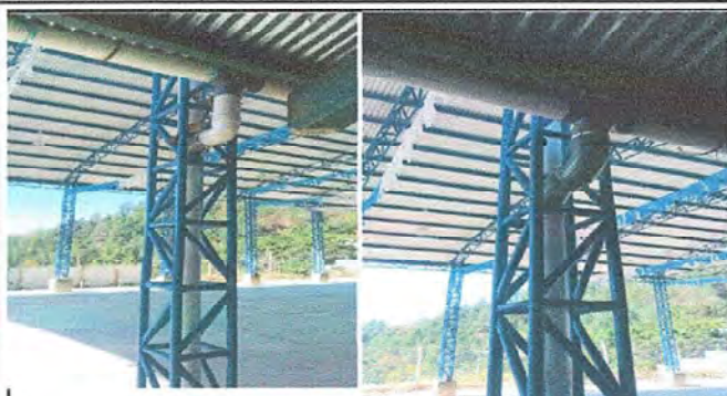
Foto13: Modulo 2: Reparación de bajada de agua pluvial, (Pegamento)
