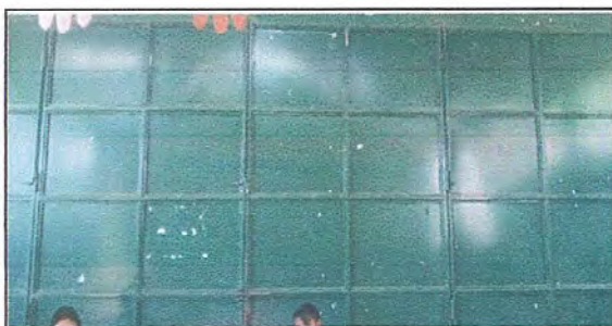
Foto 5: Módulo 2: Mantenimiento a portones de metal (Interior aulas)
