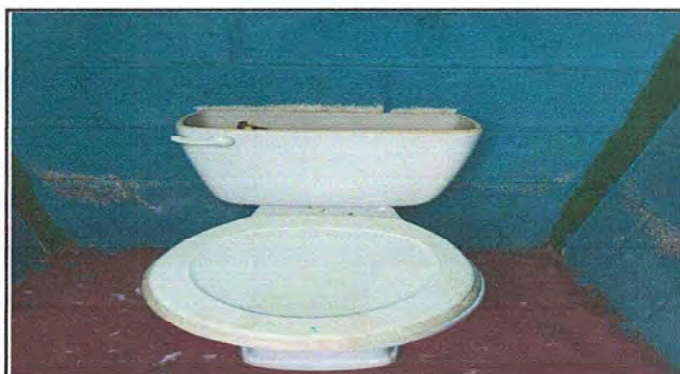
BAÑOS: Sustitución de accesorios de inodoro contrallave, tubo de arasto y tanque
