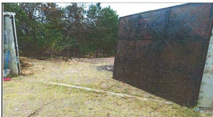
PORTÓN DE INGRESO Y EGRESO: mantenimiento de portones de metal
