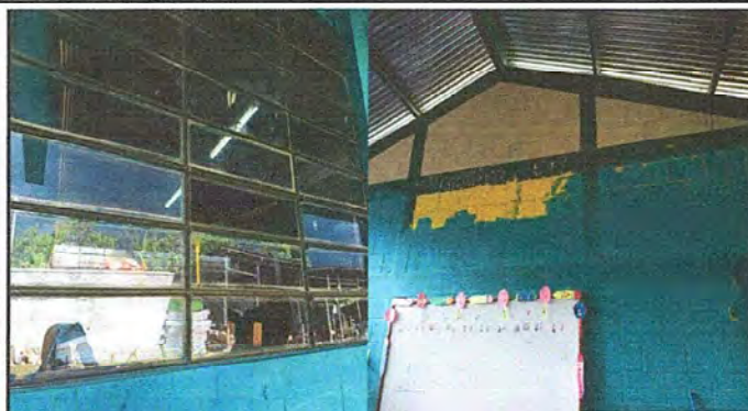
Foto1: MODULO No.1 Pintura en muros exteriores e interiores, mantenimiento de balcones de metal, fabricacion de balcones de hierro en ventanas, mantenimiento estructura de puerta lijado, cambio de tubo, cepillado, sujeciones, ampliación de pintura, suministro e instalación de canales en PVC, sustitución de vidrios
