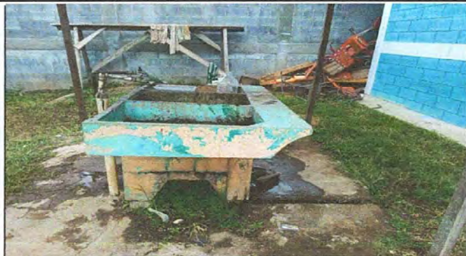
AREA EXTERIOR: Sustitución de pila plastica de dos lavaderos
