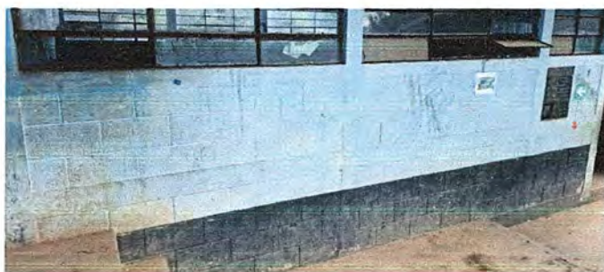
FOTO 9. PINTURA GENERAL: Pintura en muros exteriores e interiores
