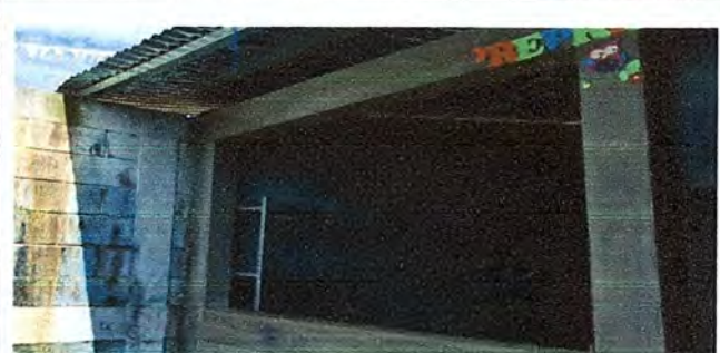
FOTO 4. MÓDULO 1: Suministro e instalación de balcón para ventana
