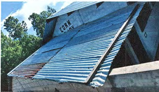
FOTO 1. MÓDULO 1: Sustitución de lámina, por lámina troquelada aluzinc
