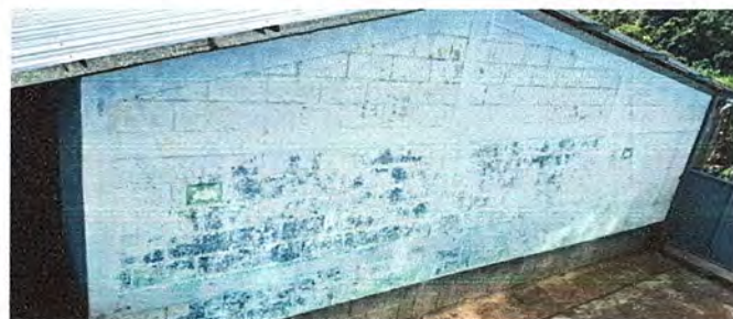
FOTO 10. PINTURA GENERAL: Pintura en muros exteriores e interiores
