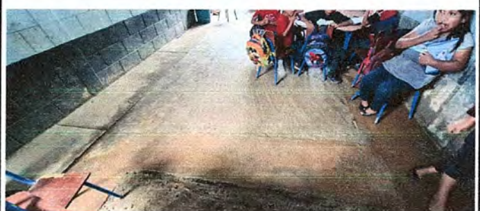
FOTO 6. MÓDULO 1: Sustitución de piso de torta por piso cerámico
