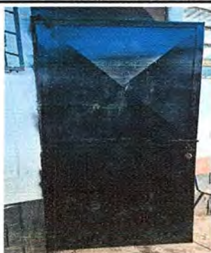
FOTO 7. MÓDULO 2: Mantenimiento de puerta
