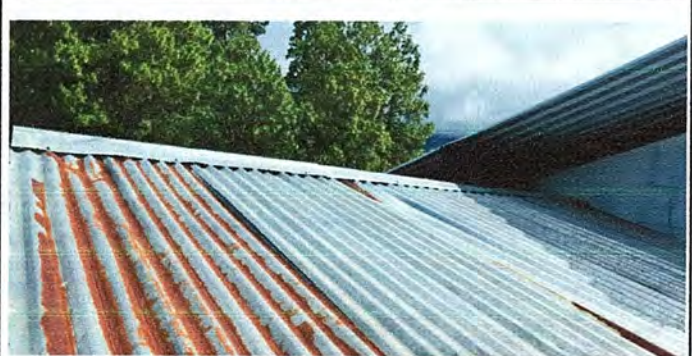
FOTO 2. MÓDULO 1: Sustitución de capote de lámina
