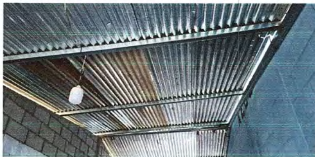
FOTO 3. MÓDULO 1: Suministro de estructura de soporte de metal
