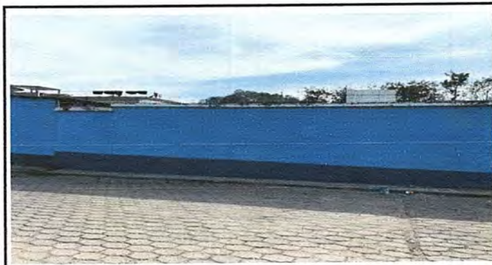
FOTO 3: MURO PERIMETRAL: * Repello en muro.
