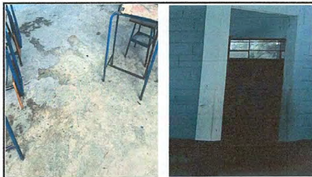
Foto 4: Modulo 2: Sustitución de piso de concreto por piso ceramico. y Sustitución de puertas de metal
