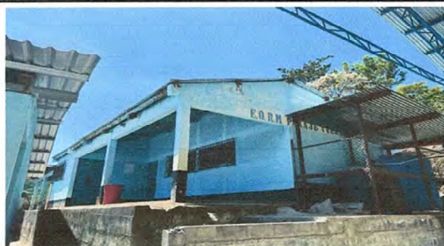
Foto 1: Modulo 1: Sustitución de lamina por lamina troquelada Aluzinc calibre 26"
