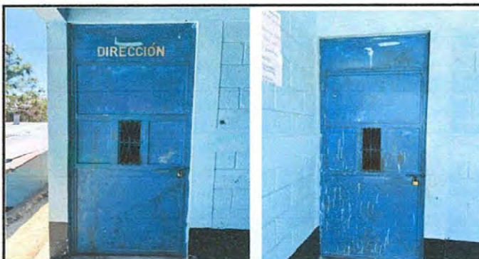
Foto 3: Modulo 1: Mantenimiento de puertas de metal (reparación, lijado y pintado)
