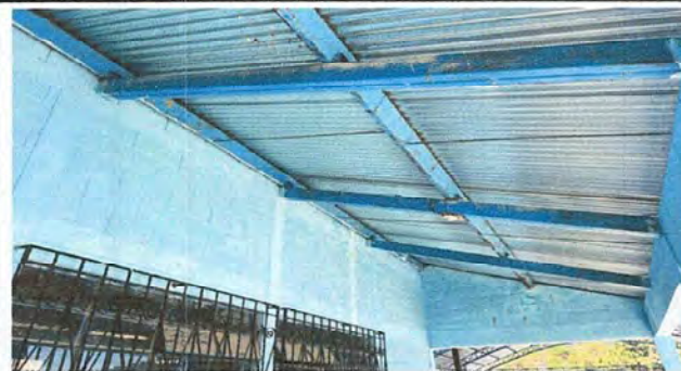
Foto 2: Modulo 1: Mantenimiento a estructura portante.
