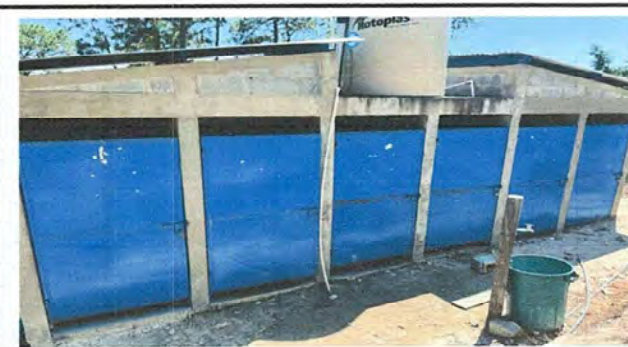
Foto 6: Modulo 4: Mantenimiento de puertas de metal (reparación, lijado y pintado)
