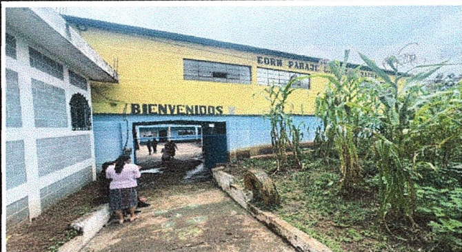
Foto1: MODULO 1: Pintura en muro exterior frontal en modulo
