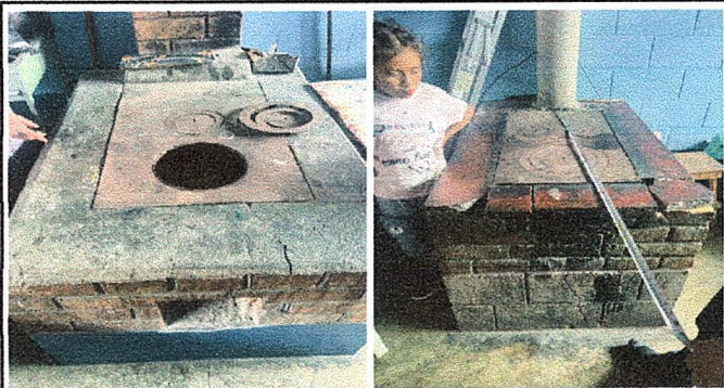
Foto 3: MODULO 2: Instalación de azulejo en estufa rural, Sustitución de chimenea de metal y Sustitución de plancha de metal de 3 hornillas
