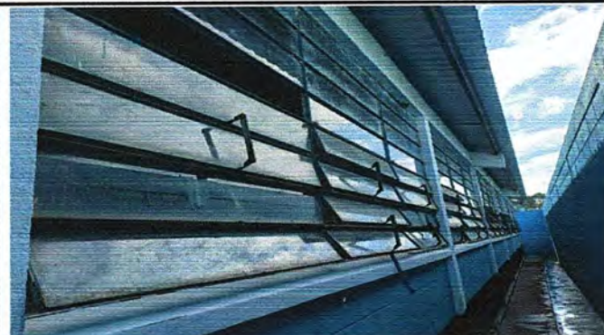
Foto 2: Módulo1:Sustitución de ventanas por pvc y vidrios (atras)
