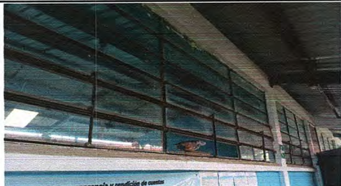
Foto1: Módulo 1: Sustitución de ventanas por pvc y vidrios (frente)
