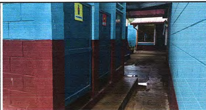
Foto 3: Módulo 1: Sustitución de puertas.
