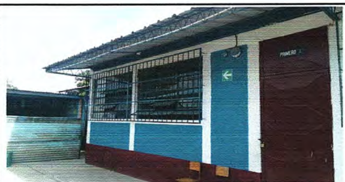
Foto 5: Módulo 2: Sustitución de ventanas por pvc y vidrios (frente)
