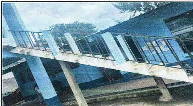
Foto 4: MODULO 2:Mantenimiento a barandas de metal
