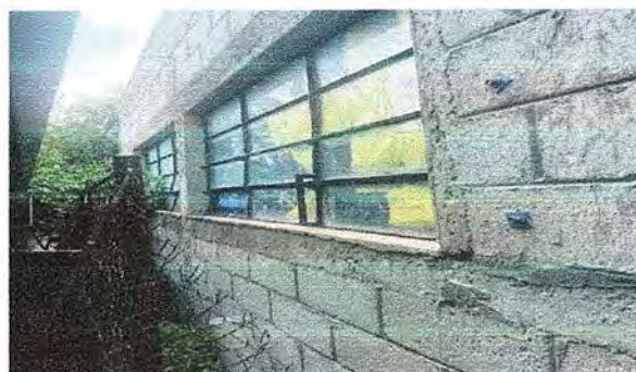
Foto 2: MODULO 1: Suministro e instalación de balcon de metal
