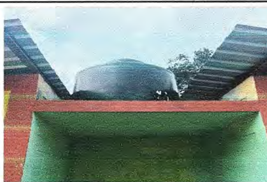
FOTO 6: BAÑOS: Sustitución de depósito de agua 1100 lt
