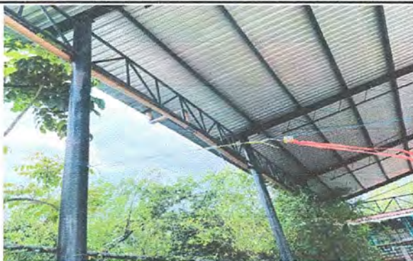
Foto 3: Sustrucción de soporte de metal para canal
