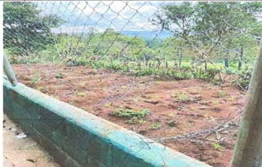
Foto 6: Reparación de muro perimetral de block con tubo hg y malla galvanizada, soleras intermedias y columnas
