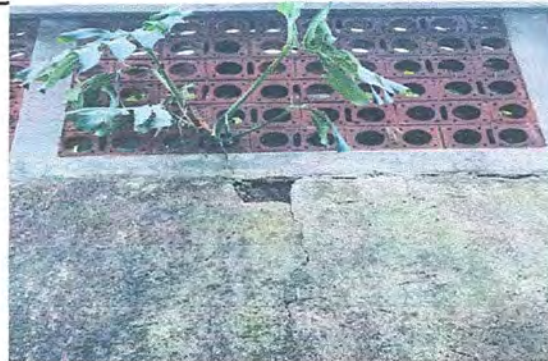
Foto 4: Repello en muro (incluye eliminacion de repello existente)
