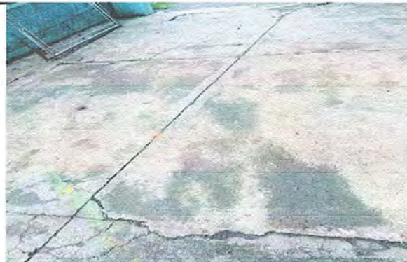
Foto 2: Cancha: Reparación de planchas de concreto de patio
