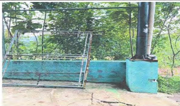
Foto 5: Sustrucción de portón de metal
