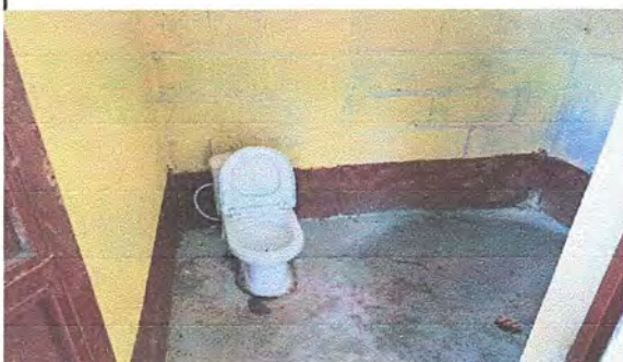
Foto 3: Módulo 1: Sustrución de tubo de abasto de sanitario
