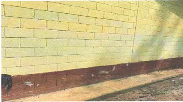
Foto 9: Módulo 1 Pintura en muros exteriores e interiores
