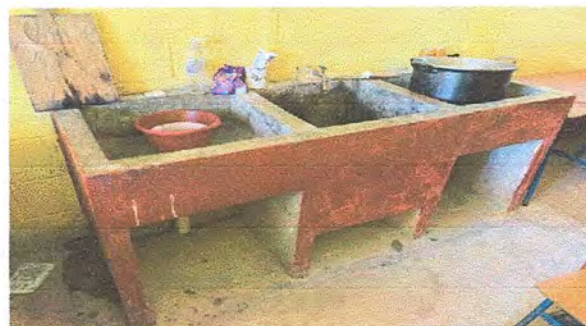
Foto 6: Módulo 1: Sustrución de pila de dos lavaderos
