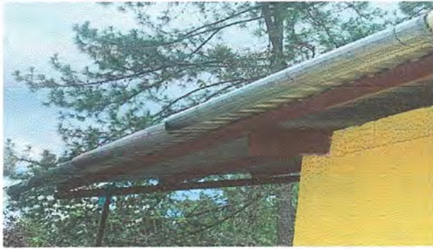
Foto 7: Módulo 1: Sustitución de canales de metal, por metal
