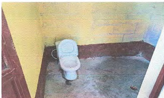
Foto1: Módulo 1 , Sustrución de piso de torta de concreto, por piso antideslizante
