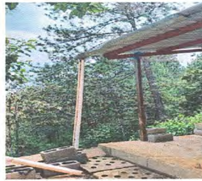
Foto 8: Sustitución de bajadas de agua pluvial de pvc, por pvc
