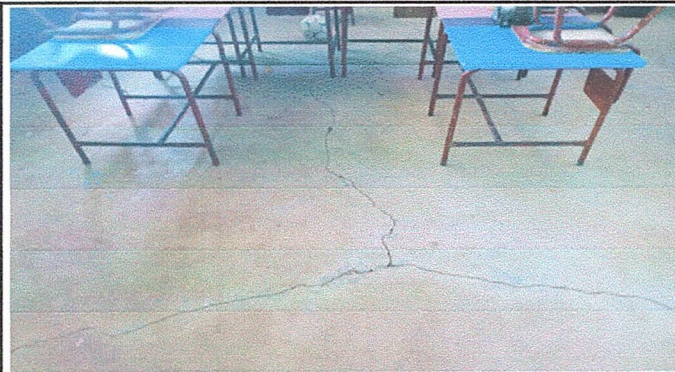
Foto1: Modulo 1: Sustitución de piso de torta de concreto, por piso cerámico
