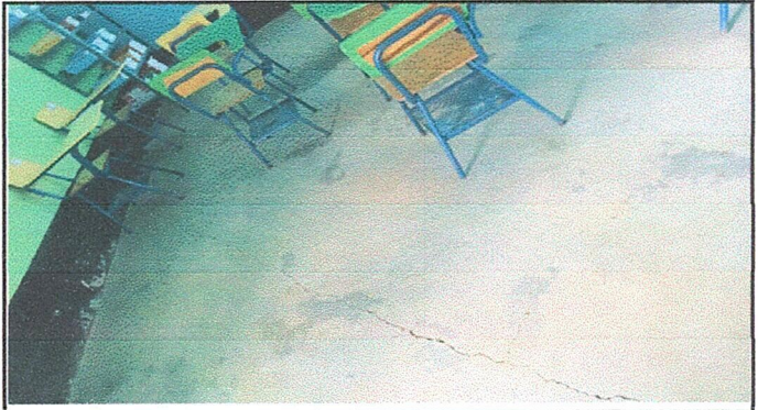
Foto 4: Modulo 1. Sustitución de piso torta de concreto por piso ceramico.
