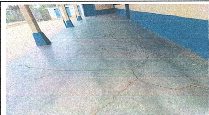
Foto 3: Modulo 3: Sustitución de piso de cemento líquido
