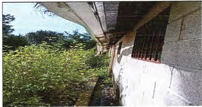
Foto 4: Módulo 1. Sustitución de canal pvc, por canal de metal
