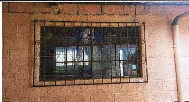
Foto 8: Módulo 1. Sustitución de estructura de metal de ventana
