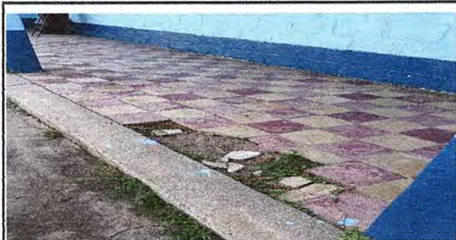
Foto 7: Módulo 1. Sustitución de piso de cemento líquido por piso granito
