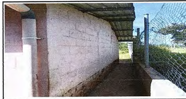
Foto 6: Modulo 1. Sustitución de bajada de agua pluvial por tubo PVC 3"
