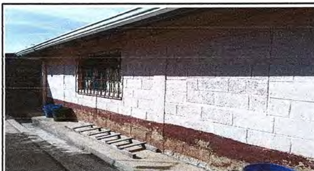
Foto 9: Módulo 1. Pintura General
