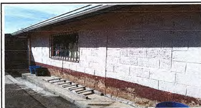
Foto 5: Modulo 1. Sustitución de soporte o pescante de metal para canal
