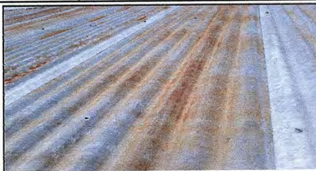
Foto 2: Módulo 1. Sustitución de elementos de fijación (tornillos).
