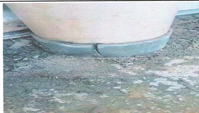
Foto 4: Sustrución de codo de bajada de agua
