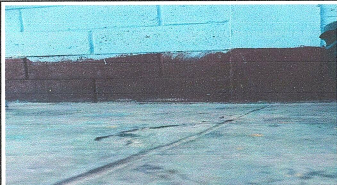
Foto1: Modulo 1: Sustrución de piso de torta de concreto, por piso cerámico
