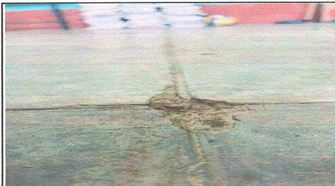
Foto 2: Modulo 2: Sustrución de piso de torta de concreto, por piso cerámico
