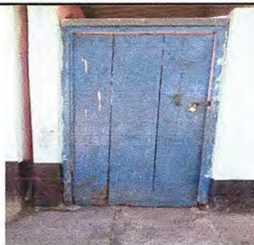
Foto 2: Modulo 1. Sustitución de puerta de madera, por metal
