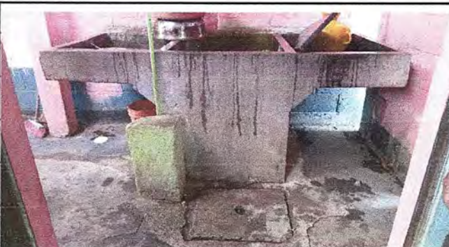
Foto 3: Modulo 1. Sustitución de azulejo en pila
