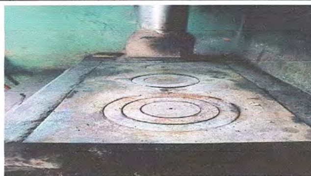
Foto 2: Módulo 2 Cocina, Mantenimiento a estufa rural
