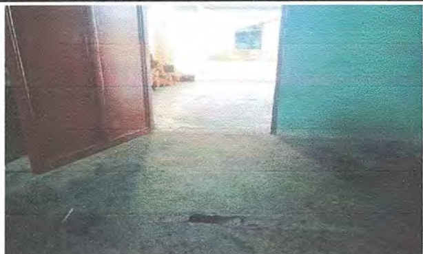
Foto1: Módulo2 Cocina, Sustitucion de piso de torta de concreto, por piso cerámico
