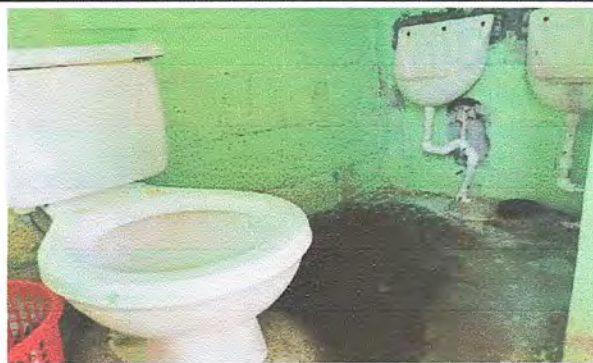
Foto 8: Módulo 5, Baños: Sustitución de piso de torta de concreto, por ceramico
