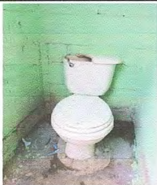
Foto 7: Módulo 5, Baños: Sustitución de inodoro
