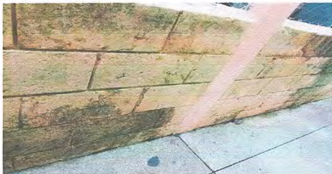
Foto 15: Pintura General: Pintura en muros exteriores e interiores.
