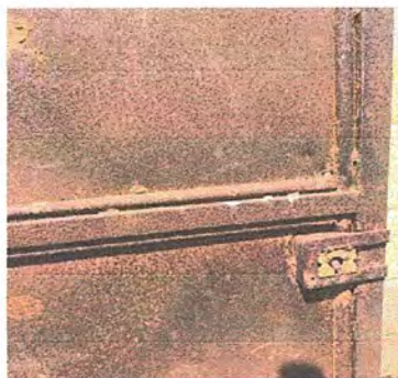
Foto 3: Módulo 2 Cocina, Mantenimiento a puerta de metal
