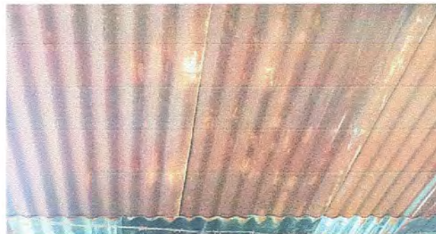
Foto 4: Módulo 5, Baños: Sustitución de lamina, por lamina troquelada calibre 26
