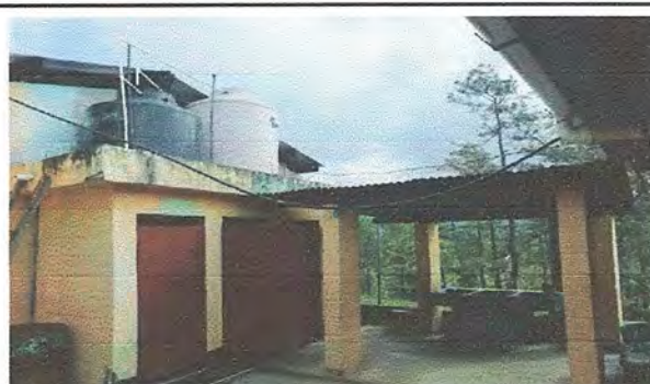
Foto 6: Módulo 5: Baños, Sustitución de estructura de soporte de madera, por metal
