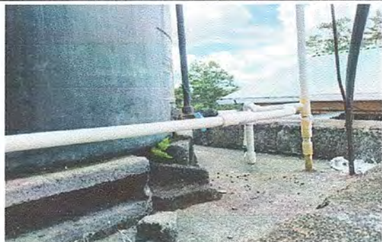
Foto 9: Módulo 5, Baños: Sustitución de tubería línea principal, instalacion de tubería principal de pvc
