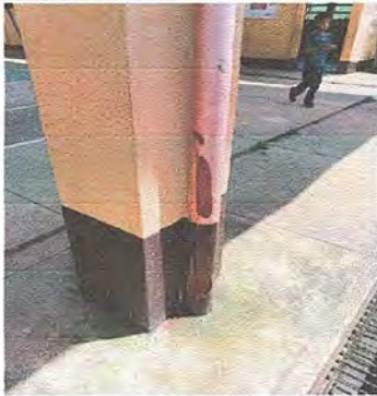
Foto 13: Reparación de bajadas de agua pluvial, tubo pvc de 3"
