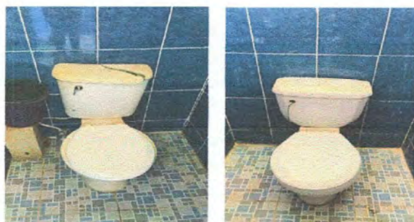
Foto 9: Sustitución de 2 inodoros completo Módulo 3
