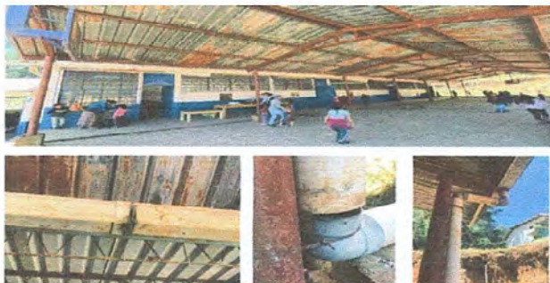
Foto 7: Sustitución de canal de PVC Módulo 2
