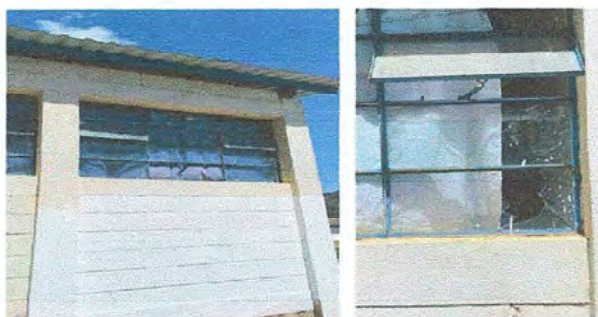
Foto 3: Sustitución de vidrios Módulo 1
