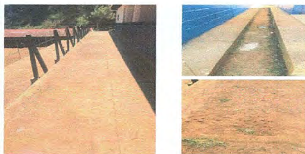
Foto 10: Reparación de Plancha de concreto de patio Módulo 4
