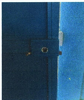
Foto 3: Módulo 1, Sustitución de chapa.
