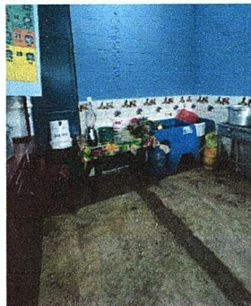
Foto 2: Módulo 1, Sustitución de piso de torta de concreto por piso cerámico.
