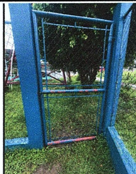
Foto 4: Módulo 1, Mantenimiento a estructura de puerta (lijado, cambio de tubo, cepillado, sujeciones, aplicaciones de pintura).
